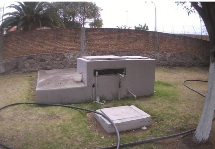
Imagen Infraestructura hidráulica cisterna en el interior del terreno Fotografía Martha de la Villa Casillas
