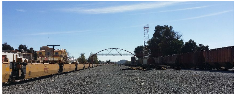
Ilustración 48 Estado actual estación Oriental (Lara Cuaya, 2016)
