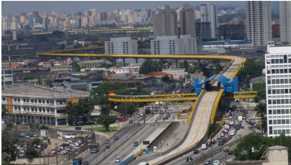
Fotografía 2. Ejemplo de paradero o estación del expreso Tiradentes vista aérea
