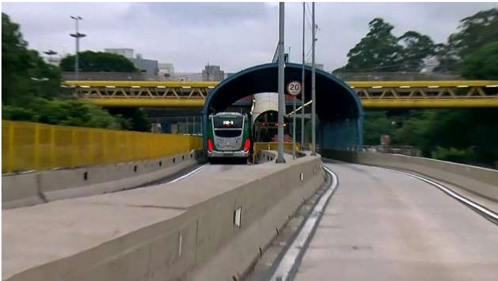
Fotografía 3. Ejemplo de paradero o estación del expreso Tiradentes vista desde carril confinado
