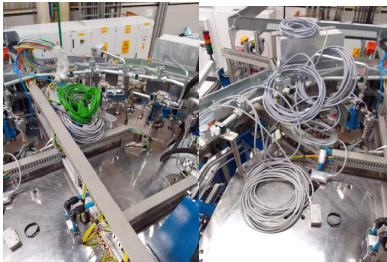
Fig. 45: Canalización de los cables de fuerza, control y comunicación hacia el tablero principal.
