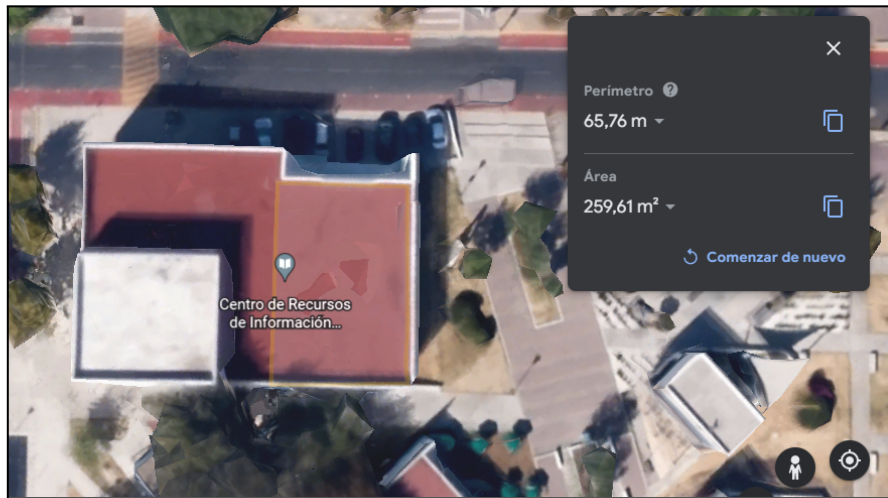
Figura 3.1: Vista aérea del edificio FCE5 (área de trabajo) [28]
