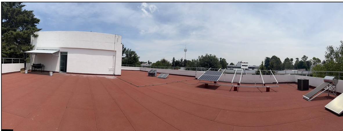
Figura 3.2: Azotea del edificio FC5 (Captura propia)
