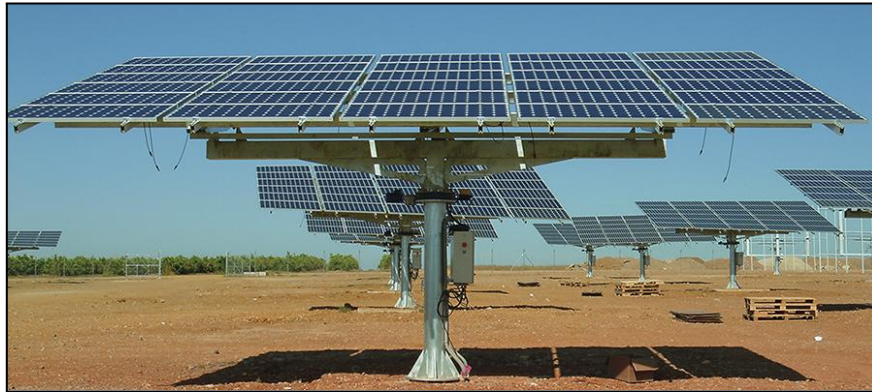
Figura 1.13: Estructura solar móvil [17]
