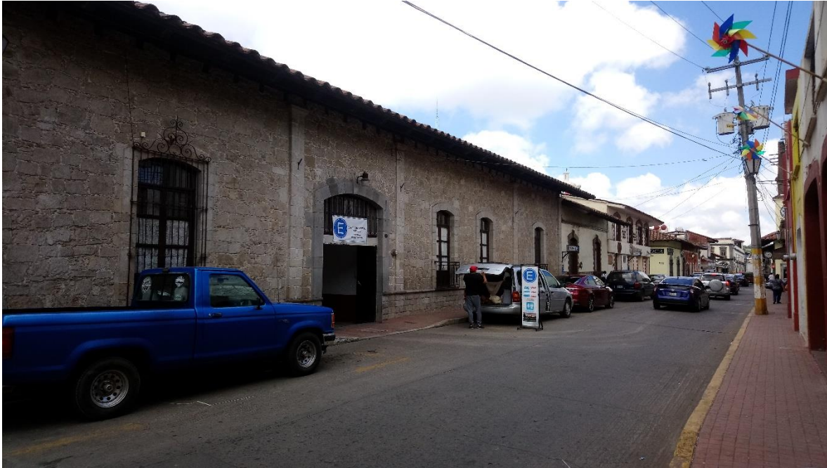
Ilustración 65 Vivienda de un nivel muro de piedra. Fuente: fotografía Flor Sánchez (2019)
