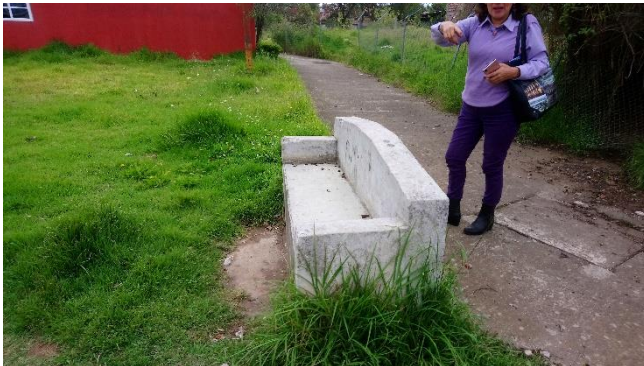
Ilustración 41 Banca del parque y registro de drenaje de la vialidad norte del terreno. Fotografía: Flor Sánchez. (2020)
