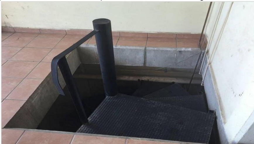
Figura 2.8. Escalera de acceso para área de descanso bodega B01, Módulo "B"
