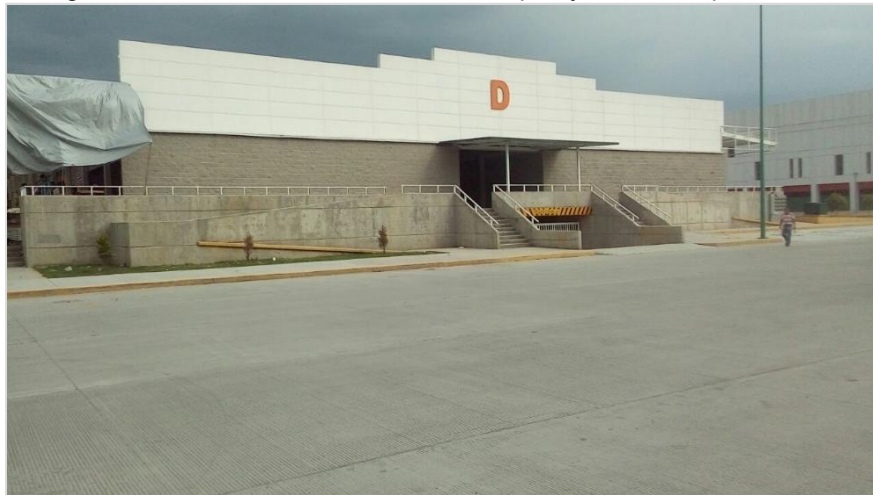
Figura 2.5. Vista frontal Módulo "D", rampas y escaleras peatonales
