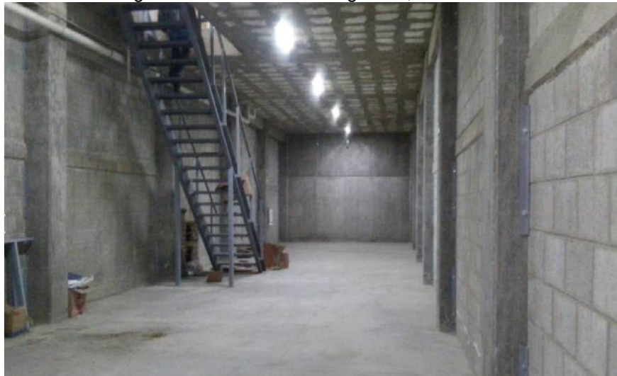
Figura 2.4. Sótano de bodega B02, Módulo "B"
