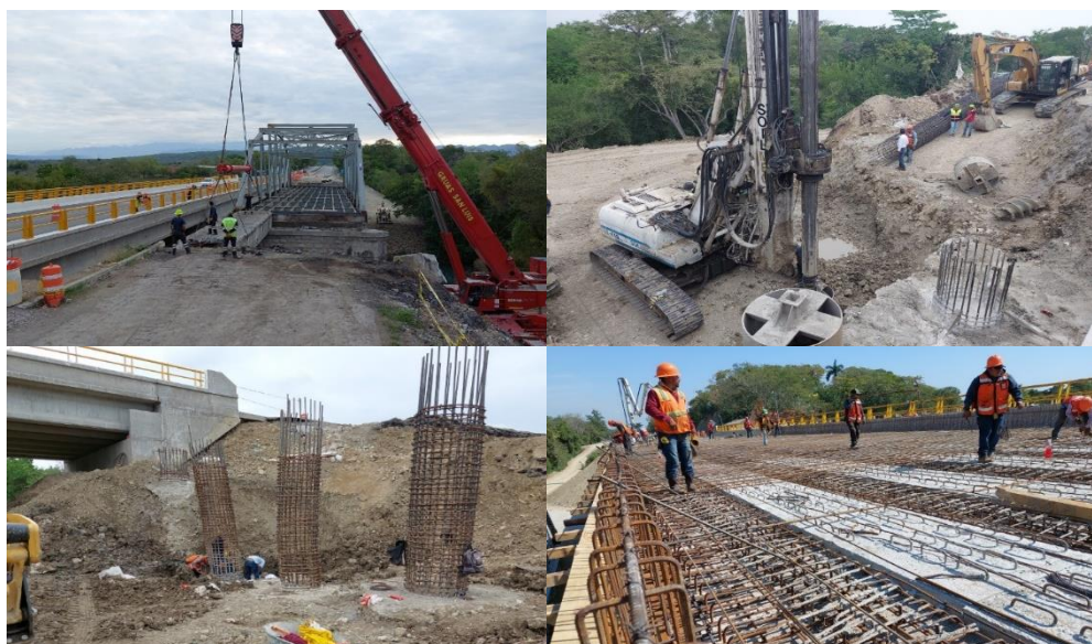
Figura 34. Ejecución de la primera y segunda etapa. (De: Reporte fotográfico)
