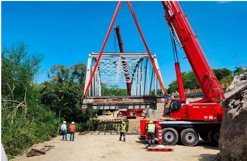
Figura 19. Retiro del puente a un costado de la carretera. (De: El pulso. Diario SLP)
