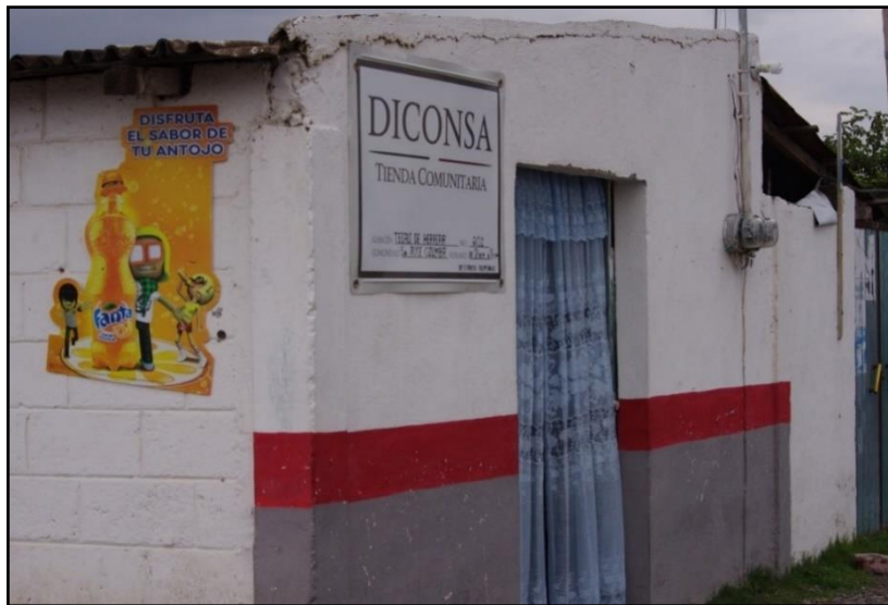
Fotografía 7. Tienda DICONSA de “San José Ozumba” antes de su reciente remodelación. (Fuente propia).
