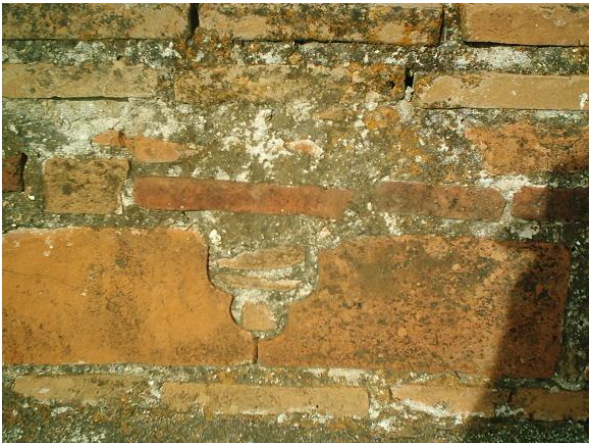
Fig. 72. Tabique en pretil con la forma de la moldura en cornisa
