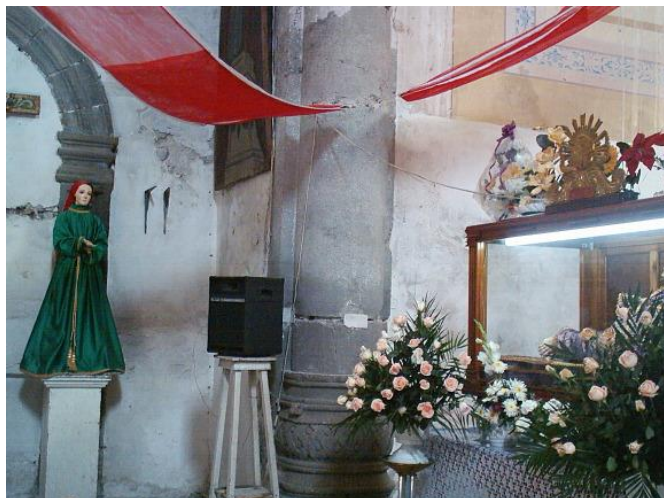
Fig. 66. Toba en Columnas de Arco Triunfal
