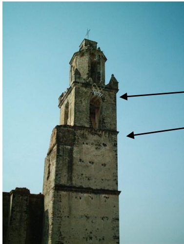
Fig. 107. Torre con desfases
