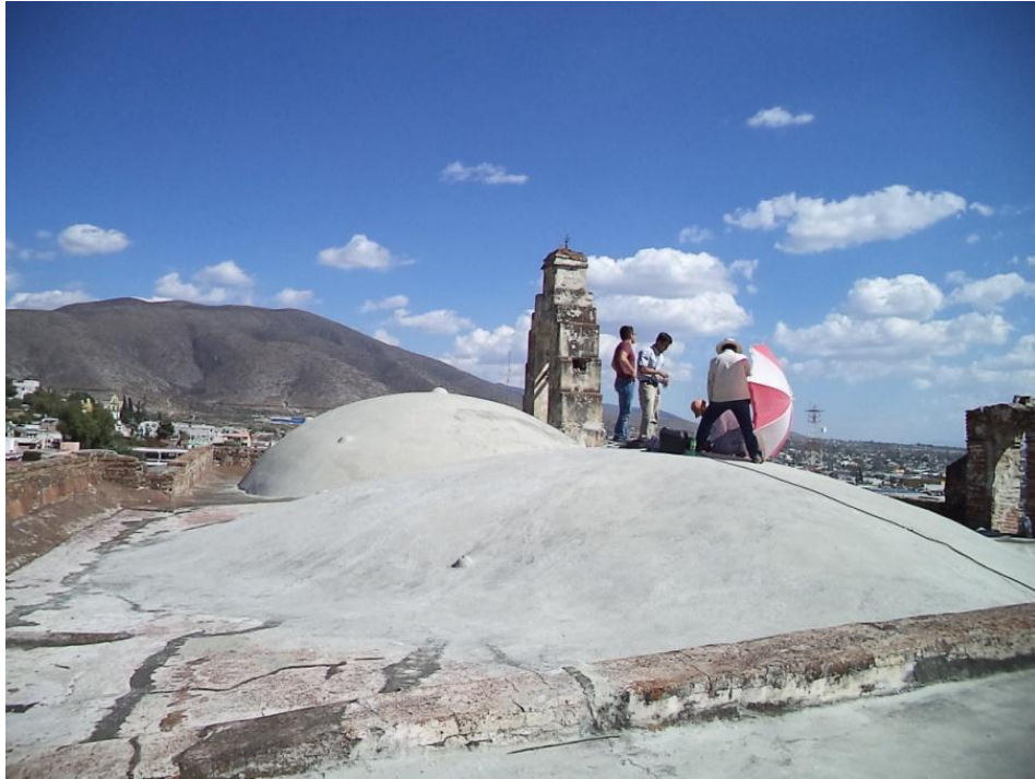
Fig. 87. Punto P-06 Medición de vibración ambiental sobre la Bóveda 2 del Recinto
