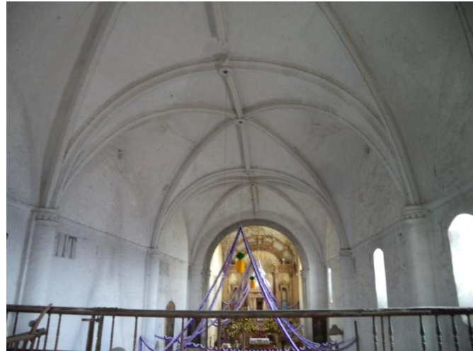
Fig. 48. Bóveda del Templo
