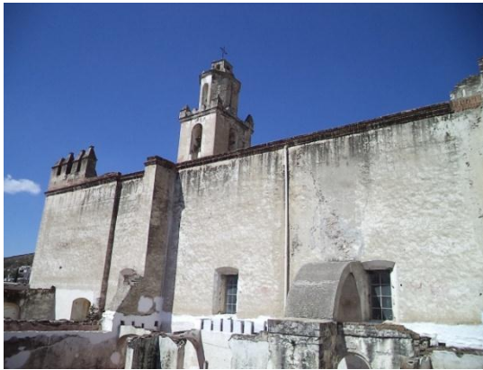
Fig. 44. Muro Sur y Contrafuertes
