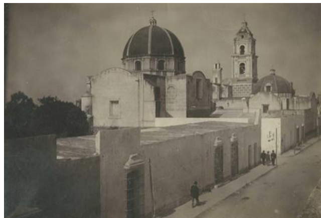
Fig. 4. La Parroquia de Nuestra Sra. de la Asunción, (en 1921), vista del ábside norte y oriente, que en el año 2014 se reparó, después de los daños causados por los sismos de 1985 y 1999.
