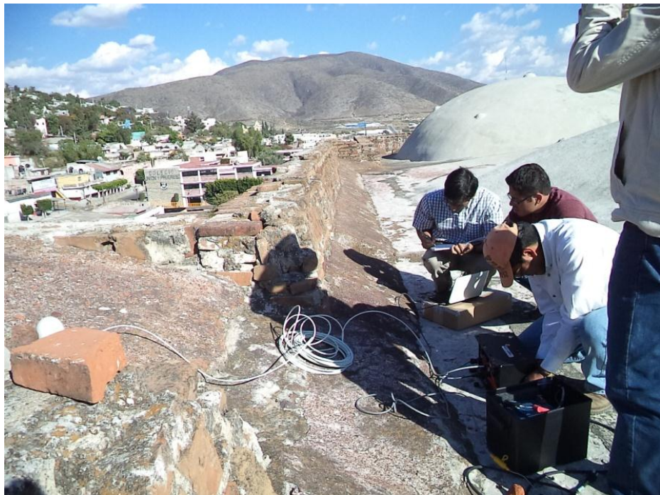
Fig. 90. Punto P-09 Medición de vibración ambiental en la azotea y centro del Edificio, sobre el Muro Lateral Norte
