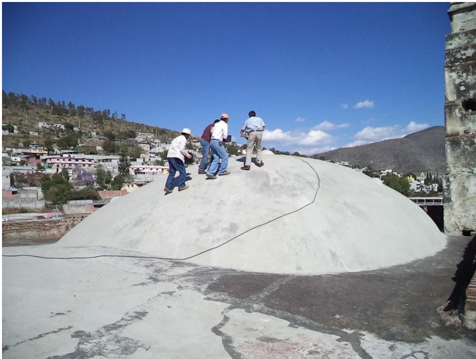
Fig. 88. Punto P-07 Medición de vibración ambiental sobre la Bóveda del altar mayor
