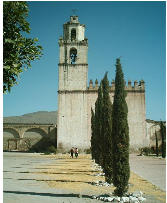
Fig. 28. Torre campanario (vista frontal)
