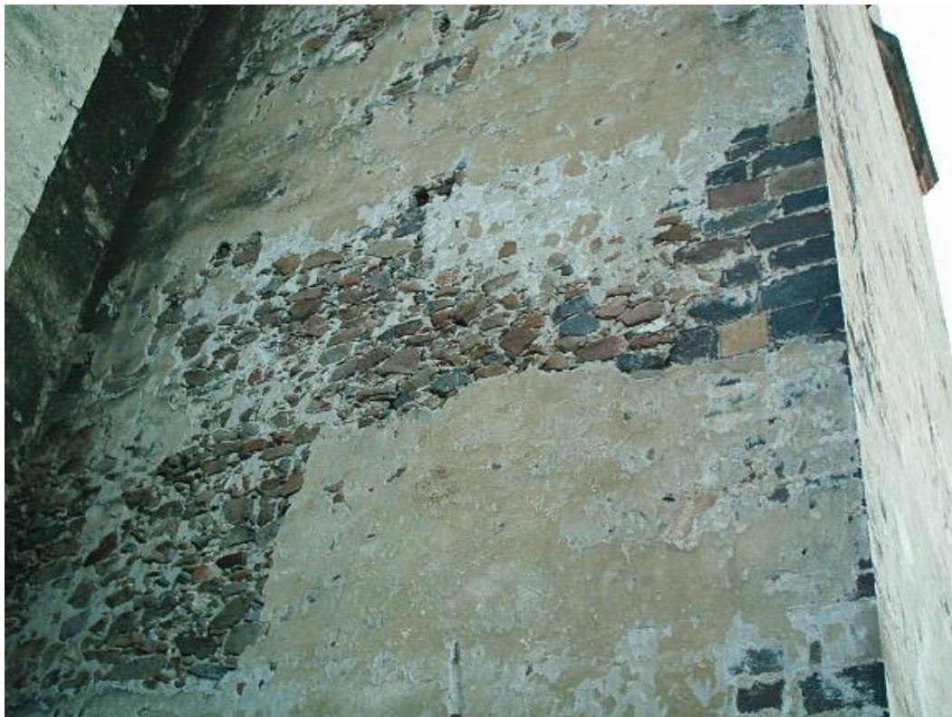
Fig. 73. Mortero en juntas de piedra y aplanados
