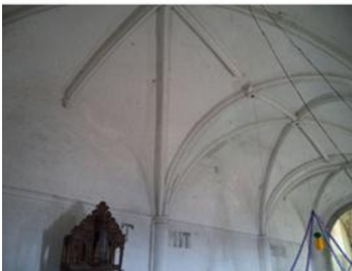
Fig. 52. Nervaduras, apoyadas en el capitel de las columnas y en los muros laterales
