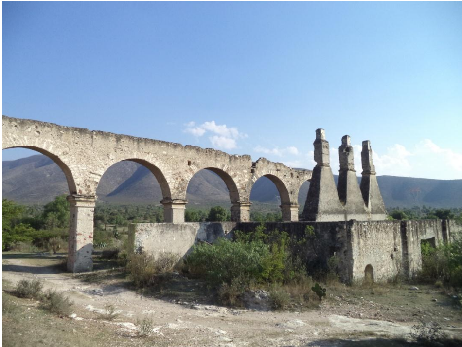
Fig. 6. La Fundición, vista noroeste
