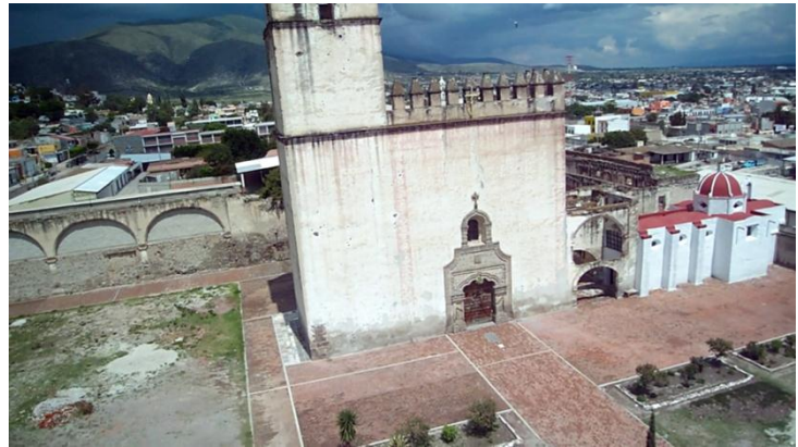
Fig. 37. Vista aérea de la Fachada y Capilla de la Tercer Orden
