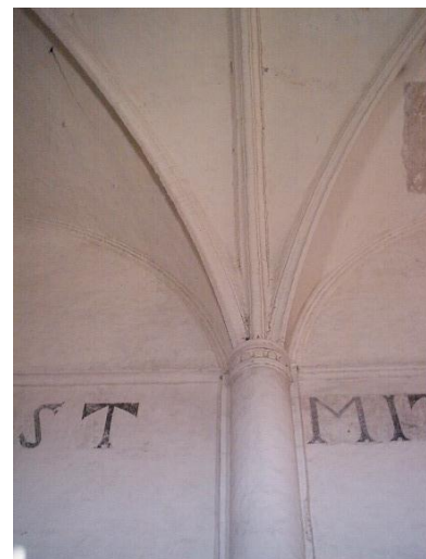
Fig. 60. Fuste o Capitel, cargando los arcos y la pechina de la bóveda
