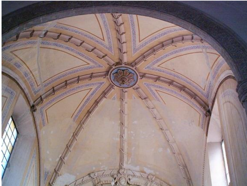
Fig. 35. Bóveda de Altar Mayor
