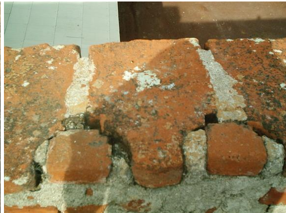
Fig. 71. Tabique en Pretil con la forma de la moldura de los arcos y nervaduras del recinto
