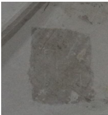
Fig. 49. Recorte de aplanado en Bóveda 3
