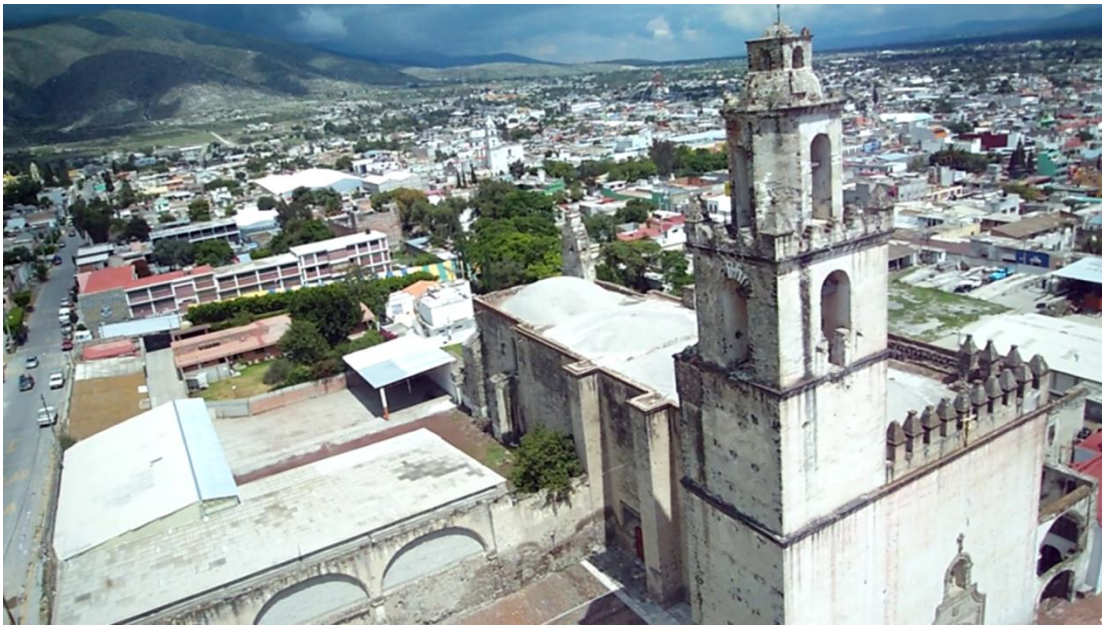
Fig. 31. Vista aérea, del punto noroeste de la Torre y la Fachada
