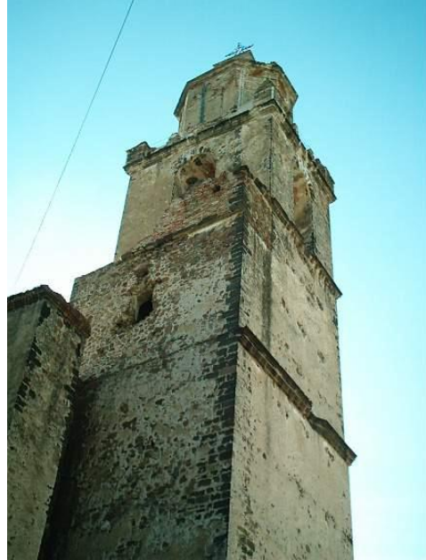
Fig. 68. Xalnene en esquinas de torre campanario
