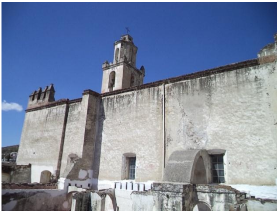
Fig. 38. Muro lateral sur y contrafuertes
