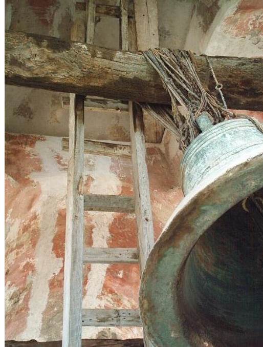
Fig. 70. Viga de Madera para soporte de campana
