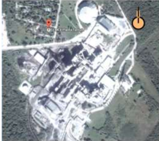
Planta Cemento Tamurín. Fuente Google Maps 2016
