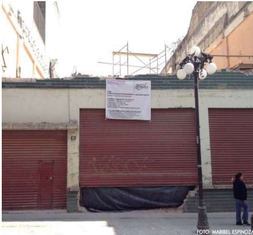
Ilustración 27 Proceso de demolición del ex club de leones. Fuente: Maribel Espinoza. Diario poblanerías Febrero 2014
