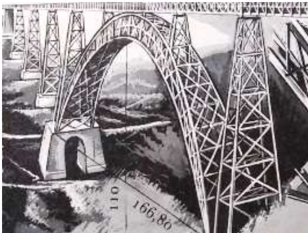
Ilustración 37. Puente Truey , cerca de Aurillac Francia 1880 Gustave Eiffel (1832-1923) Fuente: (Mansbrigde, 1969, p g. 177)
