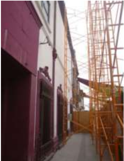
Ilustración 25. Trabajos de demolición en fachada Fuente: agresionespatrimoniosigloxxblogspot
