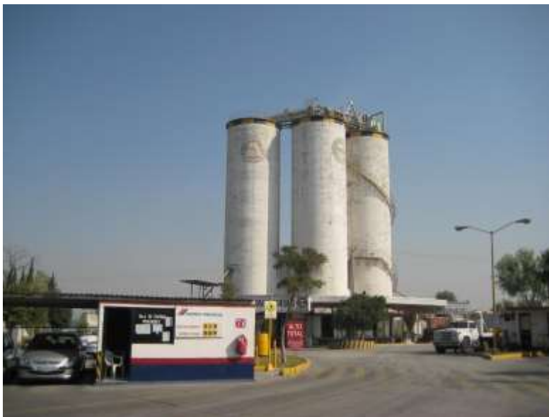
Ilustración 72. Silos de almacenamiento de cemento. Fuente: Mtra. María de la Cruz Ríos Yanes. 2012
