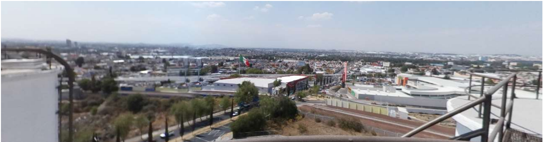
Ilustración 91. Contexto urbano de la ex fábrica cementos Atoyac, Vista Poniente. Fuente: E.P.P. 2017
