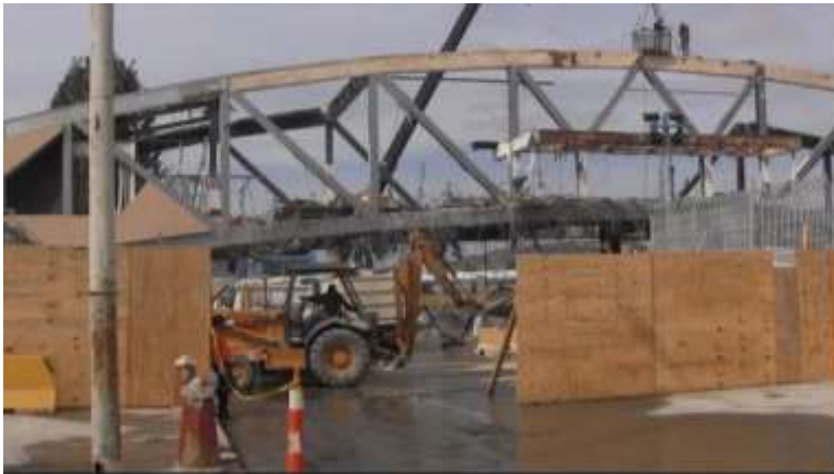
Ilustración 5. Demolición de la Puerta México. Fuente: UNIRADIO INFORMA febrero 2015
