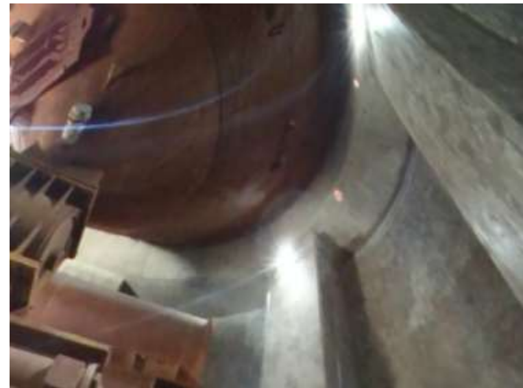
Ilustración 83 Viga circular apoyada en columnas que sostienen la tolva. Fuente E.P.P. 2017
