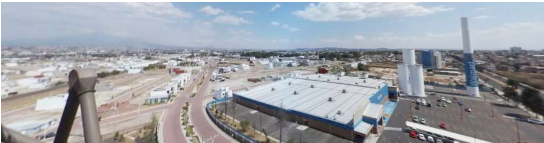
Ilustración 92. Contexto urbano de la ex fábrica cementos Atoyac, Vista oriente. Fuente: E.P.P. 2017
