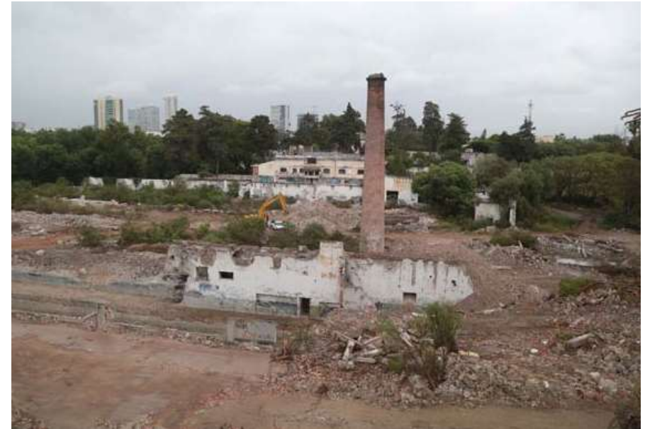
Ilustración 22. Fábrica el Mayorazgo en proceso de demolición. Fuente: José Castañeda, publicada en el diario la jornada de Oriente Abril 2015.
