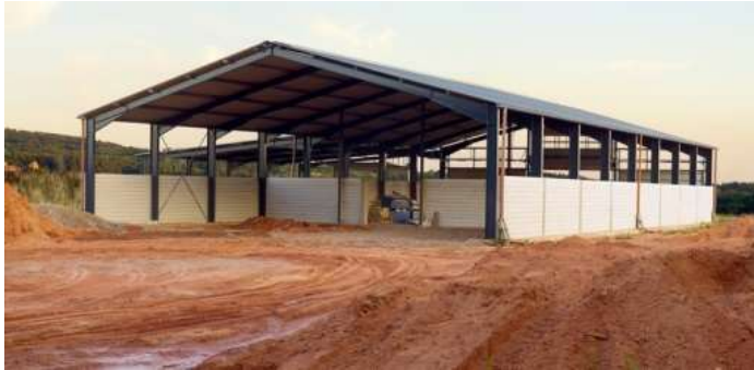
Ilustración 61. Nave industrial en proceso de construcción. Fuente: http://esnavi.com.mx/como-se-construye-una-nave-industrial/ recuperado el 06/09/2017
