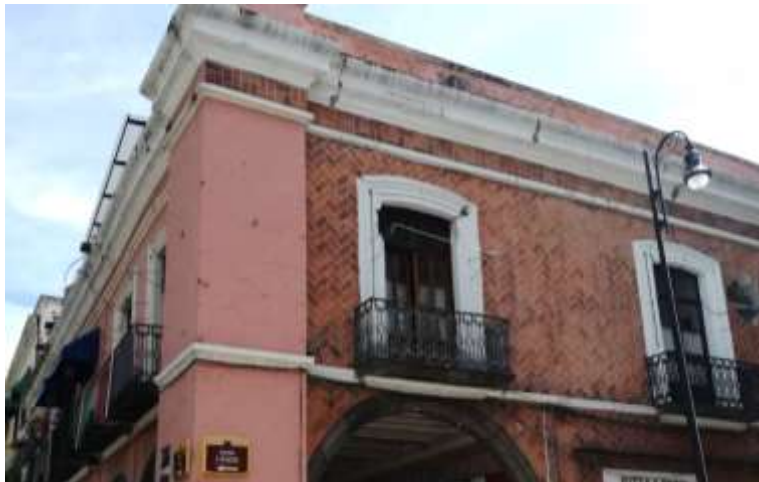
Ilustración 127 Portal de la 2 sur C.H. Puebla Pue: Fuente: E.P.P. 20 Sep. 2017
