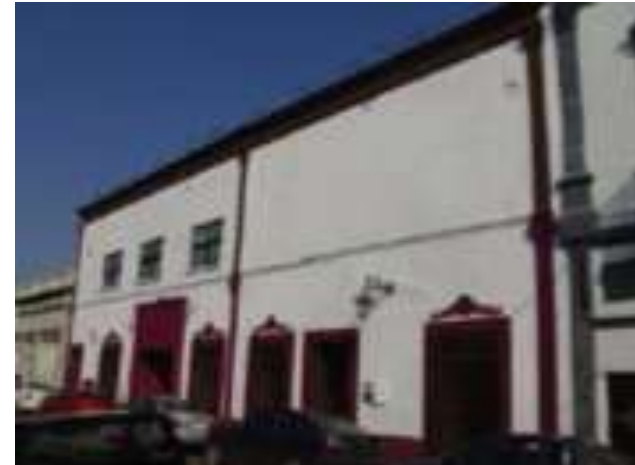
Ilustración 26. Fachada de predios destruidos. Fuente: agresionespatrimoniosigloxxblogspot
