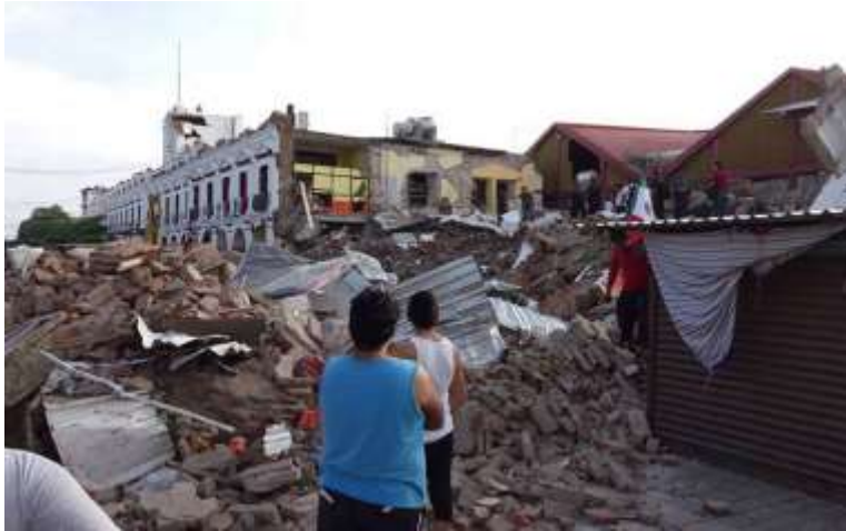
Ilustración 123 Daños por sismo en el Istmo de Tehuantepec https://www.elsoldemexico.com.mx/república/sociedad/reconstruiran-istmo-de-tehuantepec-en-4-meses-258677.html
