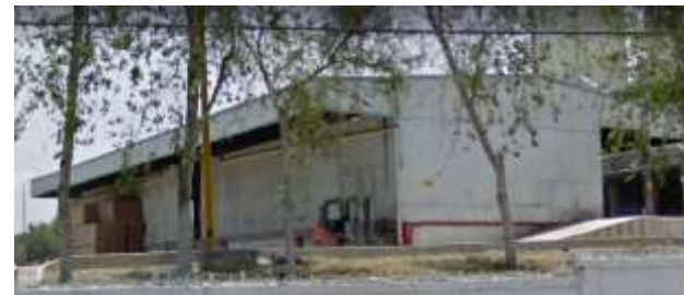
Ilustración 73. Nave de Embalaje, Fuente: Google maps 2009
