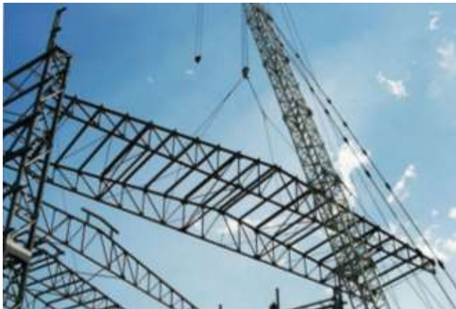
Ilustración 66. Instalación de Traveses sobre columnas de acero prefabricado. Fuente: http://www.archiexpo.es/prod/fracasso/product-90410-863860.html recuperado el 06/09/ 2017
