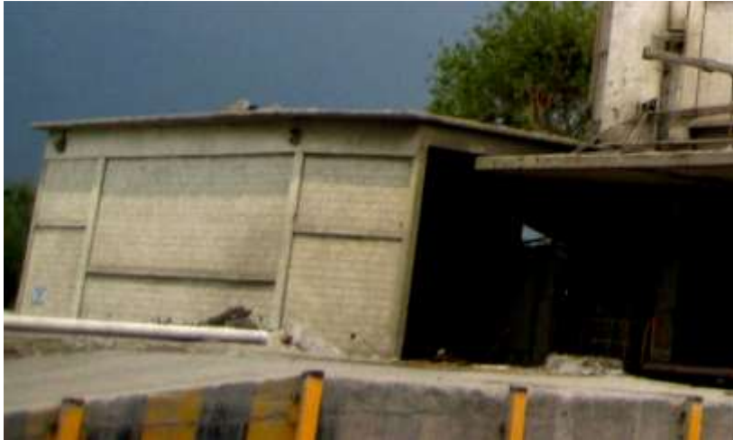
Ilustración 69. Área de traslado. Planta de fabricación "Cementos Atoyac". Fuente: Ríos Yanez 2012
