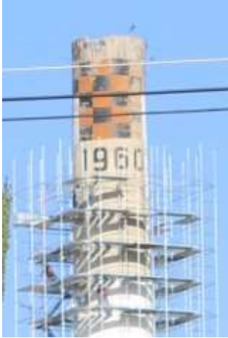
Ilustración 76. Chimenea del horno, de la Fábrica al momento de ser pintada por la empresa WalMart. Fuente. Archivo General Municipal.
