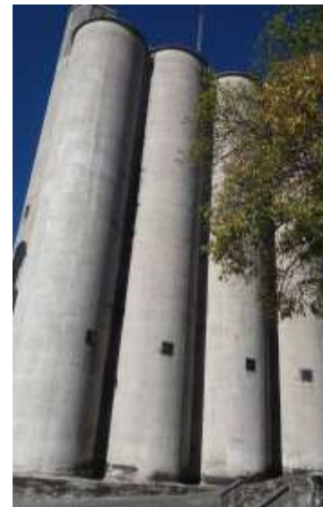
Ilustración 70. Silos de harinera ubicada en Diagonal Huexotitla 3905. Puebla, Pue. Fuente: Mtra. Carmina Fernández de Lara. Agosto 2017
