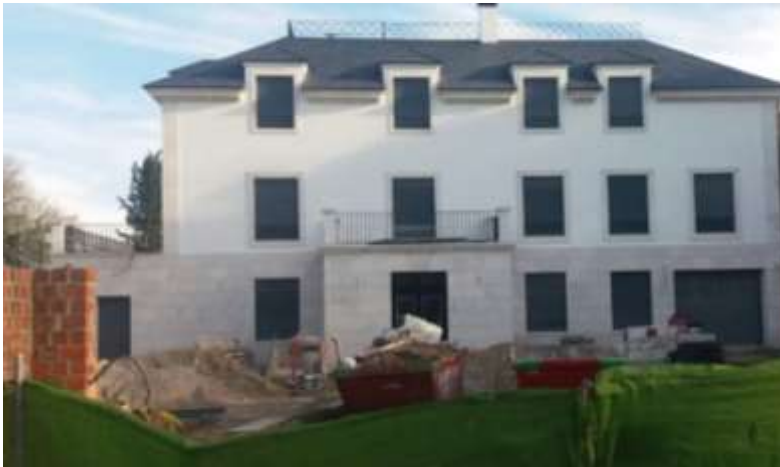
Ilustración 4. Escombro de la casa Guzmán con la construcción por la que fue sustituido de fondo. Fuente: Diario el país, Enero 2017
