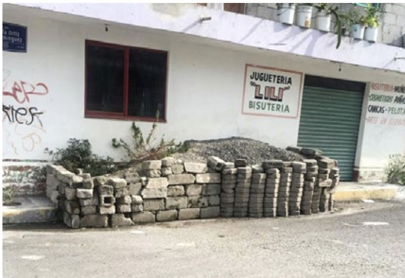
Figura 2.7. Barrera urbana: Escombros obstruyendo la acera. Fotografía propia (2019).
