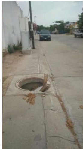
Figura 3.0. Imagen de ejemplo de barrera urbana de riesgo alto, registro sin tapa. Fotografía propia (2018).
