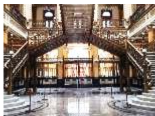
Fig. 24. Luna Mayoral, N. (2021). Herrería empleada en el Palacio de Correos, Ciudad de México. [Fotografía]. Fuente: Visita al Edificio de Palacio de Correos. Septiembre, 2019.
