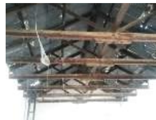
Fig. 22. Luna Mayoral, N. (2021). Cubierta hecha a base de vigas de madera, En la estación de Esperanza, Puebla. [Fotografía]. Fuente: Documentación propia
