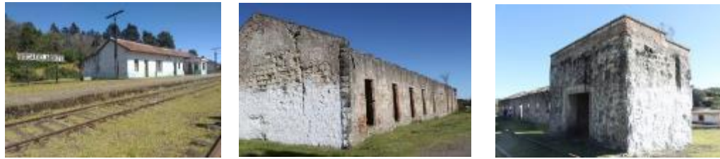
Fig. 82. Luna Mayoral, N. (2020). Tomas fijas con Cámara Digital T7 Marca: Canon. Vista de la Casa-Estación, la Casa de Sección y el Cuarto de Aceite. [Fotografía]. Fuente: Collage elaborado con fotografías tomadas con equipo propio y compartidas por el equipo de trabajo de la Maestría en Conservación del Patrimonio Edificado de la FABUAP.
