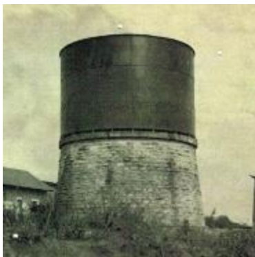
Fig. 65. Estación Café o canela. (1908). Tanque de agua de la Estación de Boca del Monte Construcción del tanque de agua en 1908. [Fotografía]. Fuente: https://www.facebook.com/la.estacion.cafe.o.canela/photos/a.829221183808819/2269596999771223
