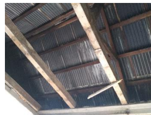
Fig. 21. Luna Mayoral, N. (2021). Vigas de madera para la elaboración de cerchas en cubierta, en la Estación de Boca del Monte. [Fotografía]. Fuente: Documentación propia
