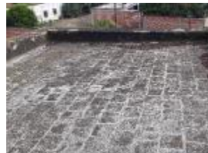
Fig. 16. Luna Mayoral, N. (2021). Ladrillo de barro recocido utilizado como material constructivo en la Casa de Cultura de San Luis Tehuiloyocan, Puebla. [Fotografía]. Fuente: Documentación propia
