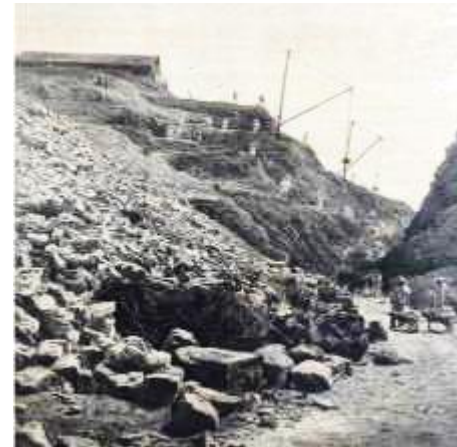
Fig. 186. Baz, G. Y Gallo, E.L. (1874). Trabajadores en las Cumbres de Maltrata. [Ilustración]. Fuente: Historia del Ferrocarril Mexicano , p. 224.
