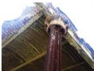
Fig. 25. Luna Mayoral, N. (2020). Estructura a base de hierro fundido utilizado en la Estación de Esperanza, Puebla. [Fotografía]. Fuente: Documentación propia.
