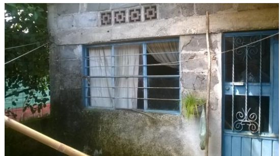
Vista del patio posterior del inmueble.
