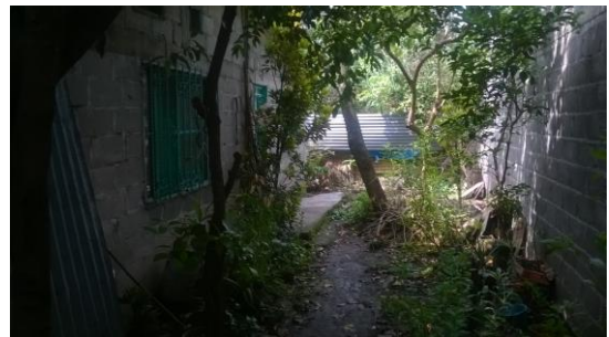
Vista del jardín lateral del inmueble desde la parte posterior del mismo.
