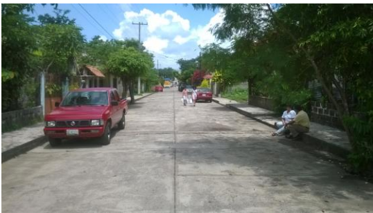
Vista del inmueble desde la avenida 5 con dirección poniente.
