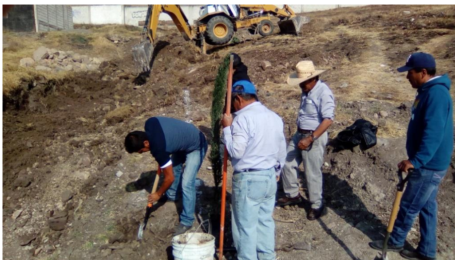
Figura 27 Construcción del canal pluvial
