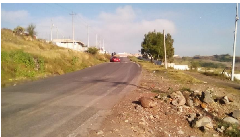
Figura 22 Avenida 11 sur, carece de infraestructura vial
