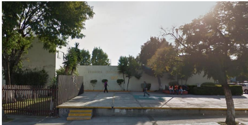
Figuras 26. Fachada de la Guardería Infantil IMSS
