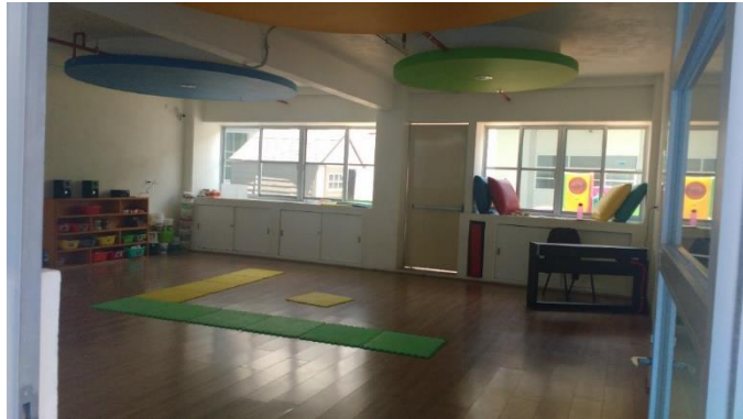
Figura 43. Trabes y columnas en aulas Circulo Infantil
