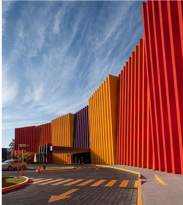
Figuras 28. Formas Irregulares En La Fachada de Del Hospital Infantil Teletón De Oncología
