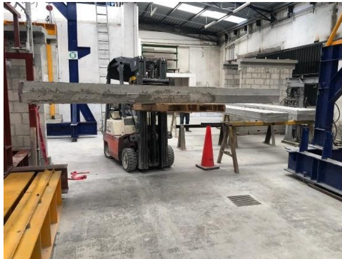
Figura 4-7 Transporte con montacargas
