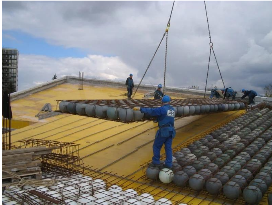
Figura 1-8 Sistemas Bubbledeck o losas con burbujas de aire
