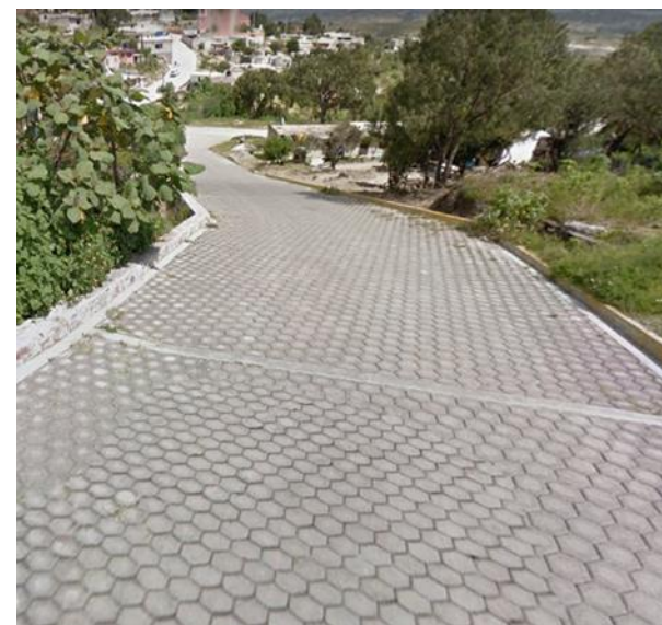
Ilustración 13 Vialidad Adoquinada en Los Ángeles Tetela.
