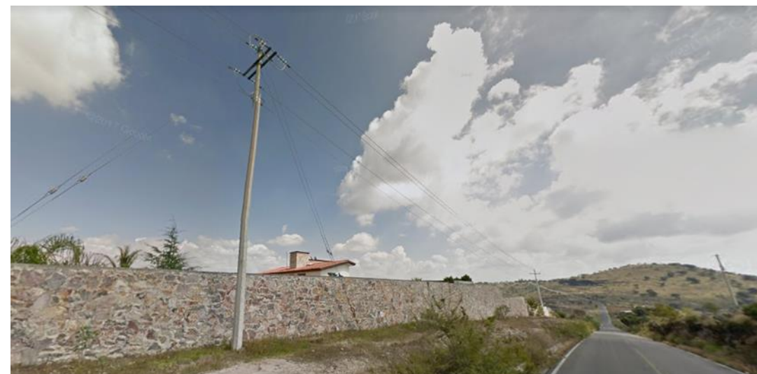
Ilustración 12 Poste de Energía Eléctrica sobre vialidad principal en Los Ángeles Tetela.
