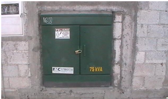
Fig. 1.9 transformador tipo pedestal
