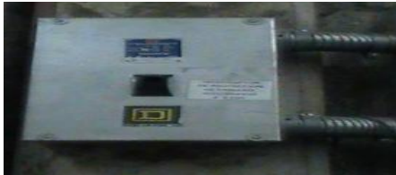
Fig. 1.1 Interruptor secundario
