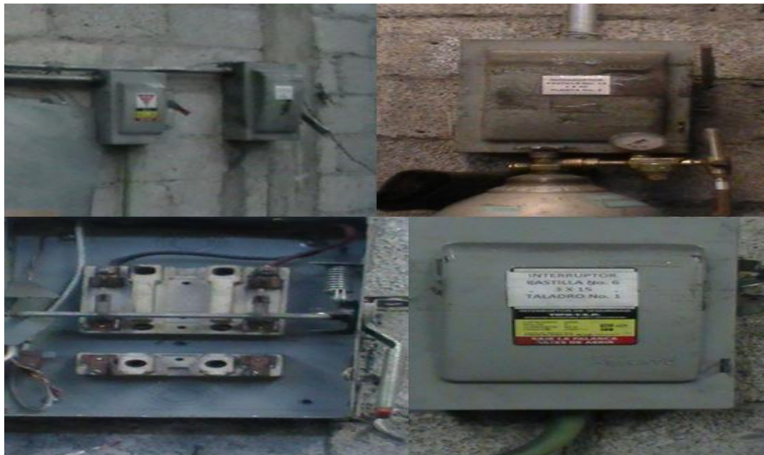
Fig. 1.4 Desconectores
