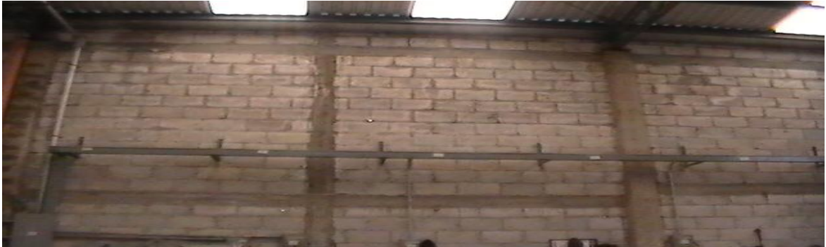
Fig. 1.3 Ducto metálico con tapa
