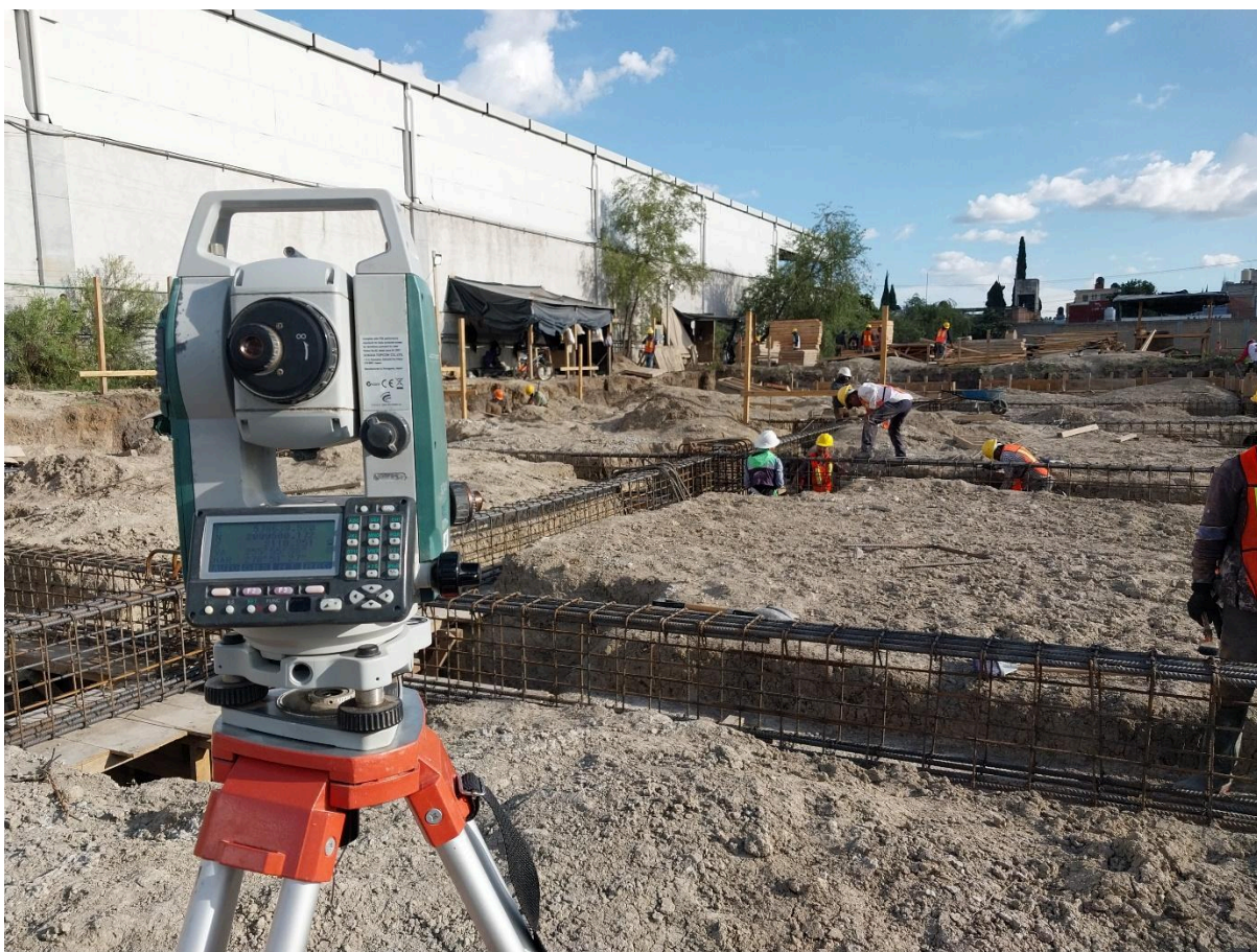
Figura 20. Revisión de niveles para la cimentación. (Imagen propia)
