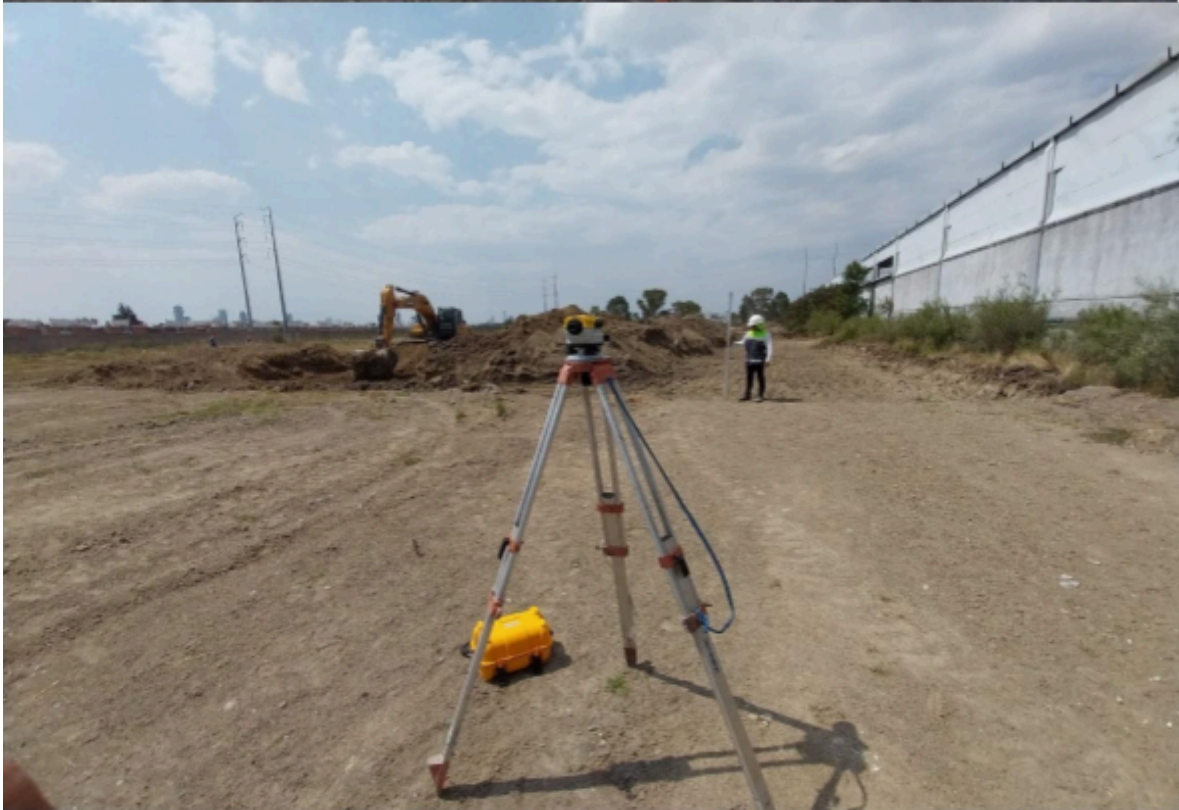
Figura SEQ Figura \* ARABIC 18. Elaboración del establecimiento de puntos de control y marcaje en campo. (Imagen propia)
