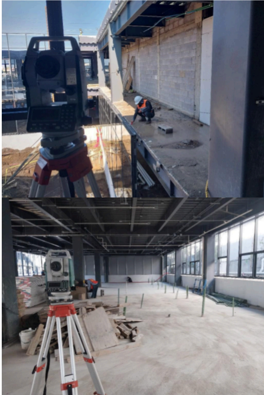
Figura SEQ Figura \* ARABIC 23. Ejecución de elementos interiores. (Imagen propia)
