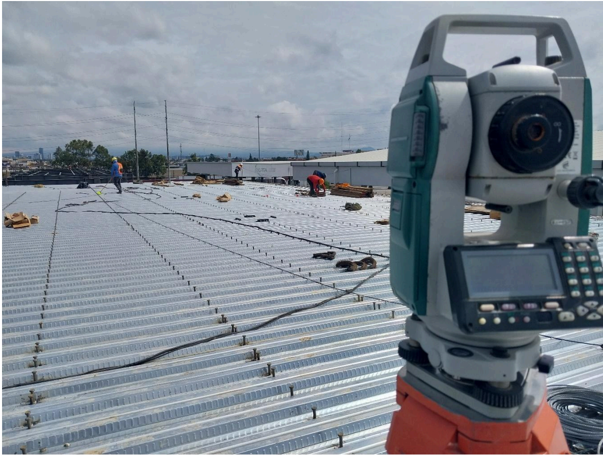
Figura 22. Control de losas. (Imagen propia)
