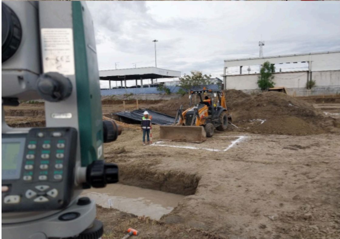
Figura SEQ Figura \* ARABIC 19. Marcaje de elementos estructurales y excavaciones. (Imagen propia)
