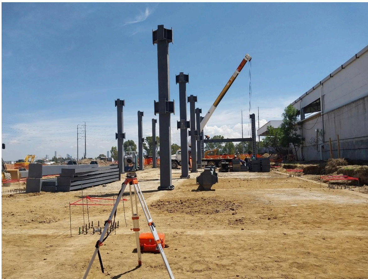
Figura 21. Control en montaje vertical. (Imagen propia)
