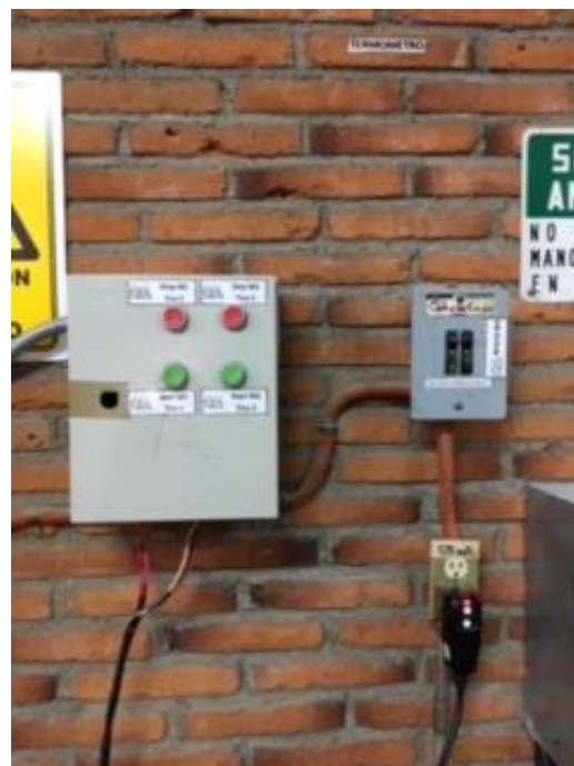
Ilustración 15. Centro de carga y control de Tina 2
