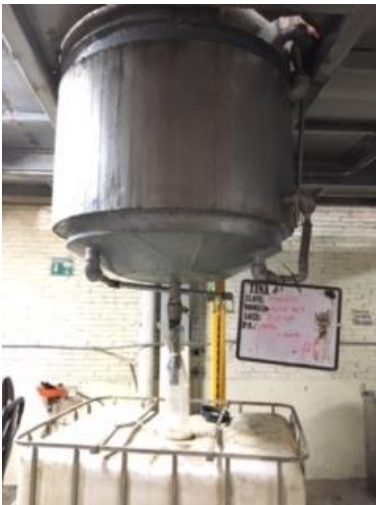
Ilustración 9. Tina 4. Vista desde segundo nivel
