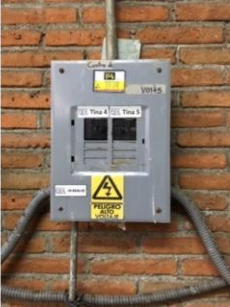
Ilustración 8. Centro de carga de Tina 4 y 5
