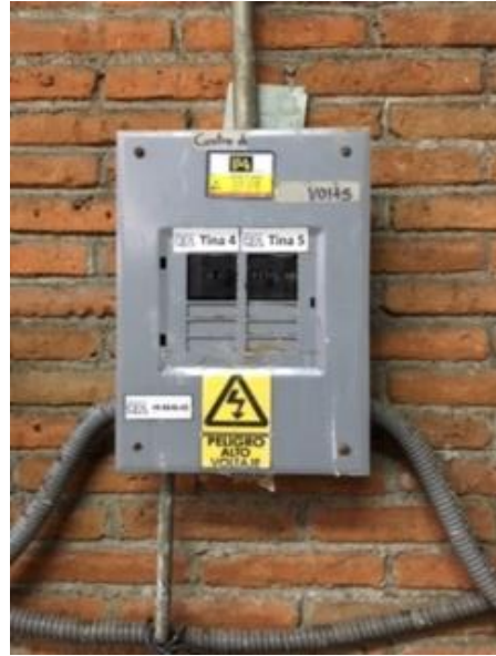
Ilustración 11. Centro de carga de Tina 4 y 5
