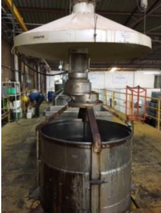
Ilustración 18. Tina 1, vista desde segundo nivel
