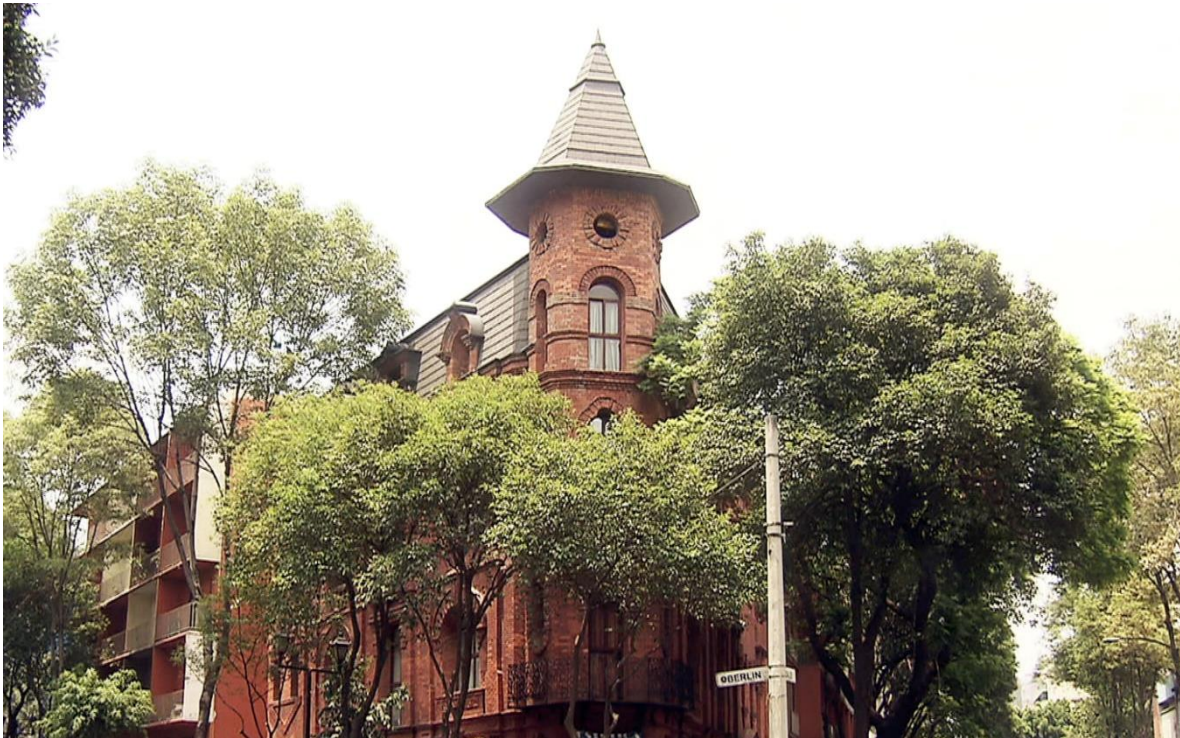
Fotografía 11 Residencia obra del Ing. R. A. Pigeon en esquina de Berlín y Versalles, Colección Carlos Villasana y Raúl Torres/MAF, 31/Mayo/2013
