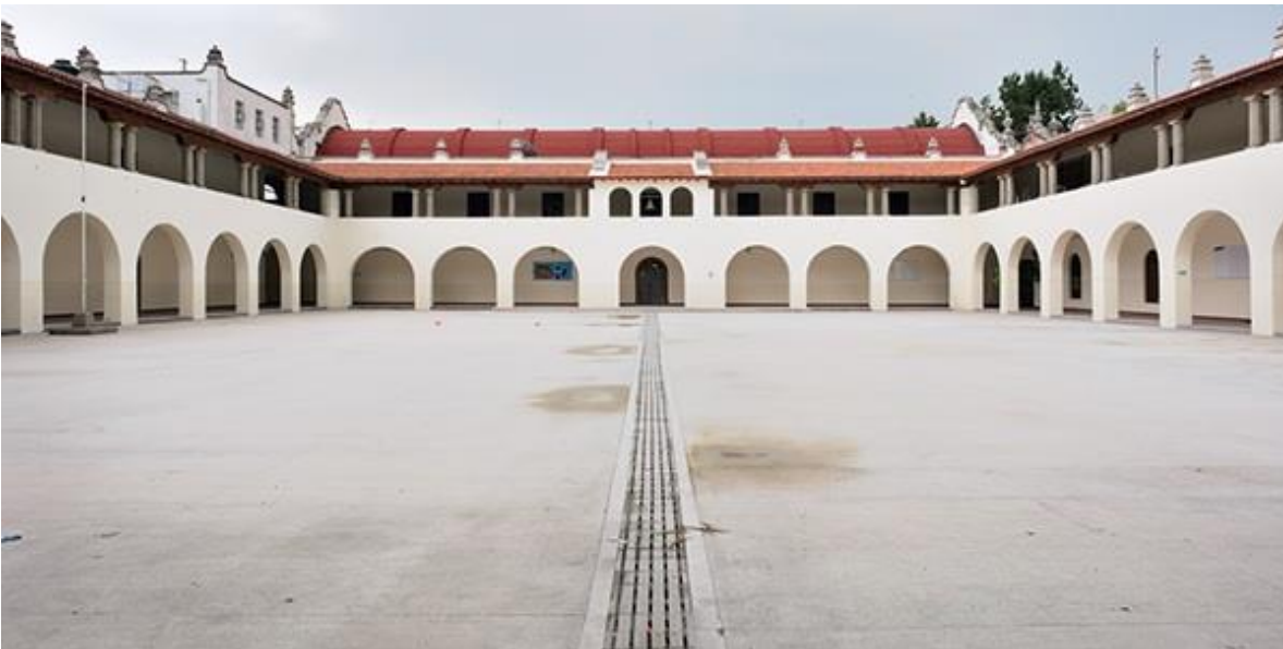
Fotografía 31 Patio interior con arcadas de Centro Escolar Benito Juárez, Col Roma, Colección Eduardo Gutiérrez/ https://www.behance.net ,13/Dic/2013
