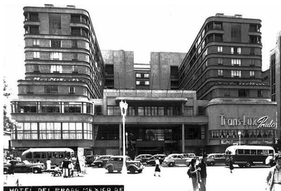
Fotografía 45 Fachada Principal Hotel del Prado, extraída de: https://www.maspormas.com/cdmx/9-hoteles-historicos-de-la-cdmx/
