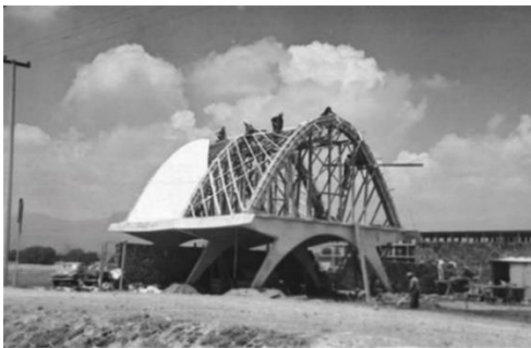
Fotografía 58 Etapa de construcción de estructura extraída de:
