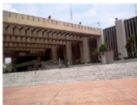
Edificio de la Delegación Cuauhtémoc, 1972, Teodoro Gonzales de León, foto tomada de internet 2017.
