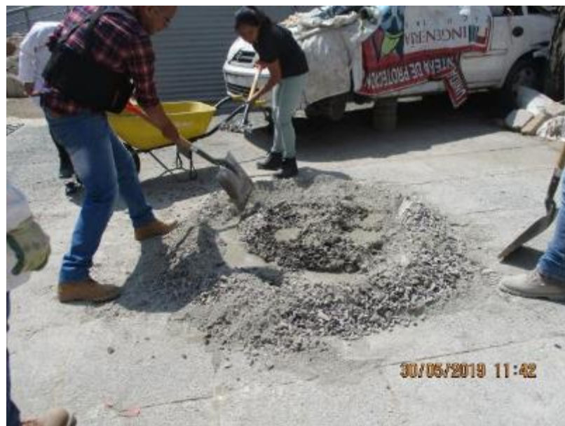
Figura 3-11 Preparación del concreto
