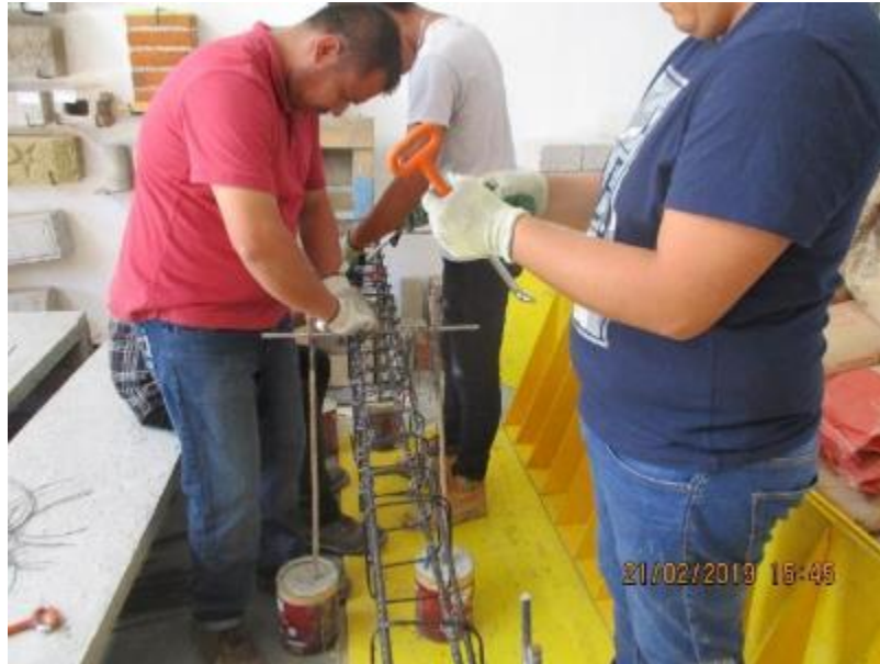
Figura 3-7 Habilitado del acero de refuerzo
