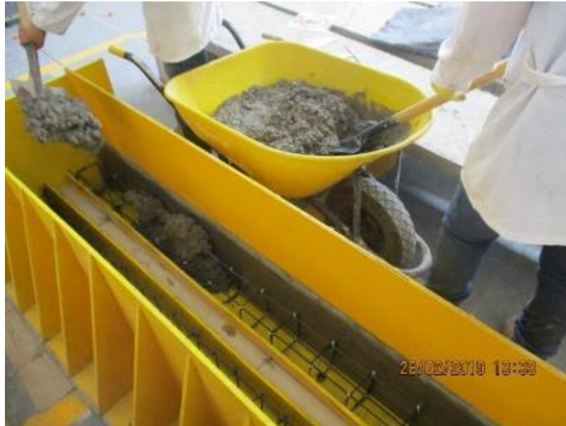
Figura 3-12 Colado del concreto
