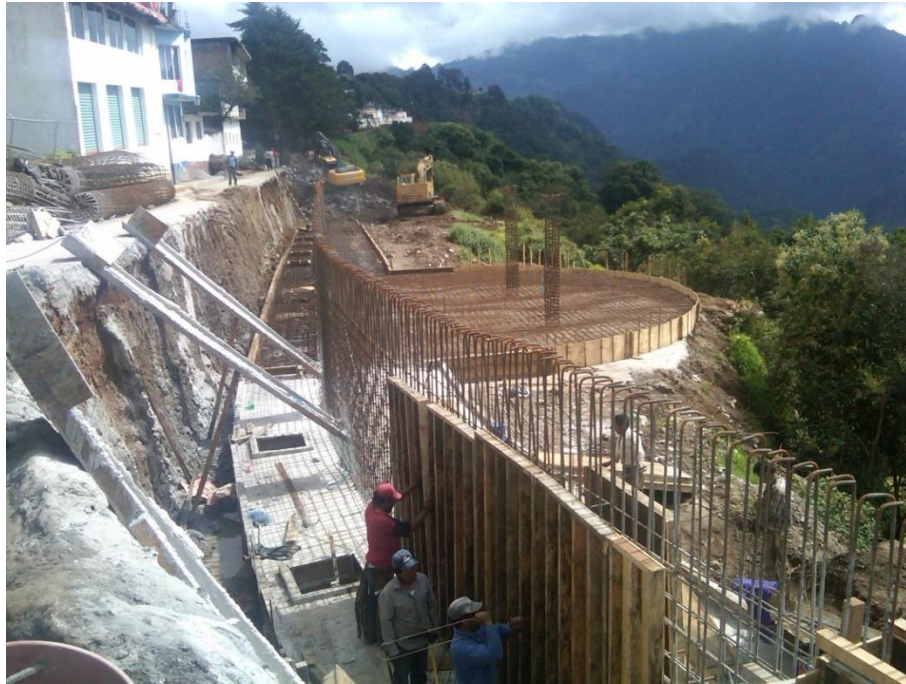
Fotografía 1.- Panorámica del frente de obra km 0+400 aprox. (Área mirador).
