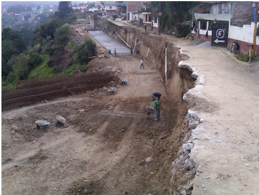
Fotografía 2.- Panorámica del frente de obra km. 0+650
