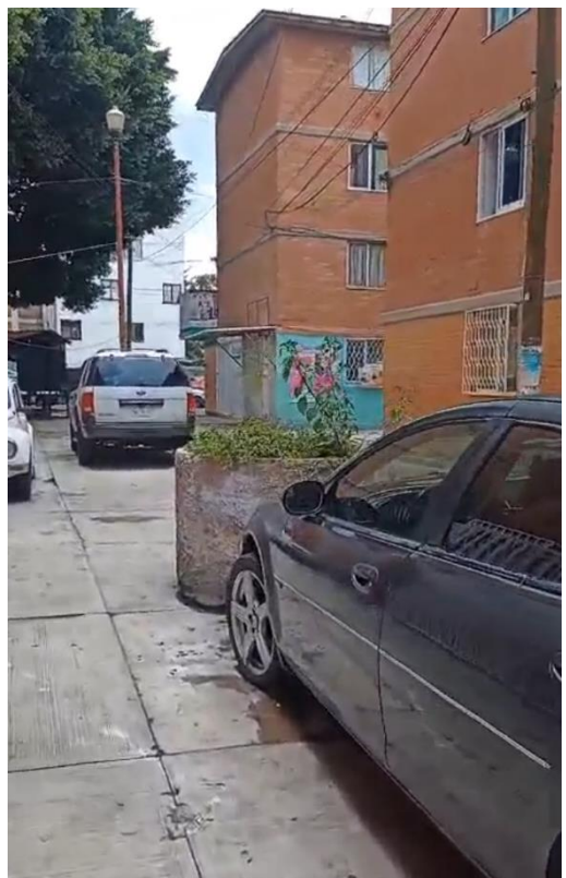
Fotografía 16 Edificaciones e instalación eléctrica 03 – Elaboración propia – 01-06-24 , Unidad habitacional Margarita
