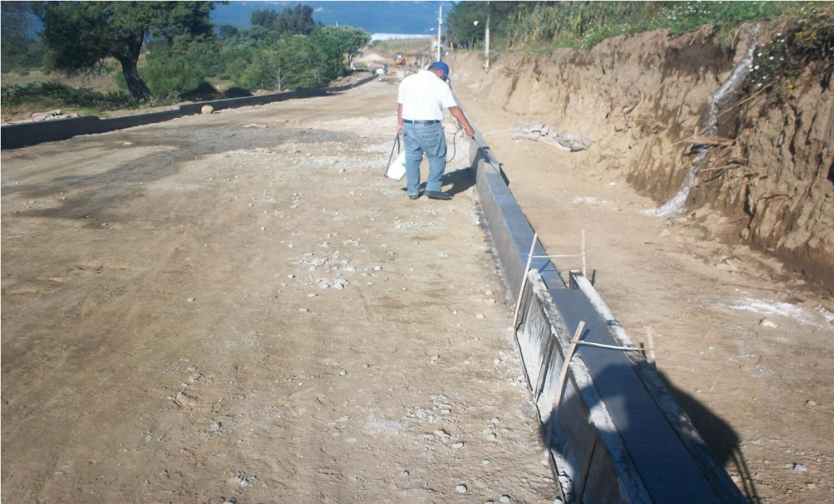
COLADO DE GUARNICIONES
