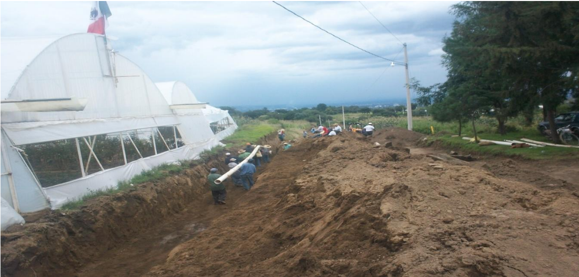
REUBICACION DE LA TUBERIA FUERA DEL AREA DE LA VIALIDAD
