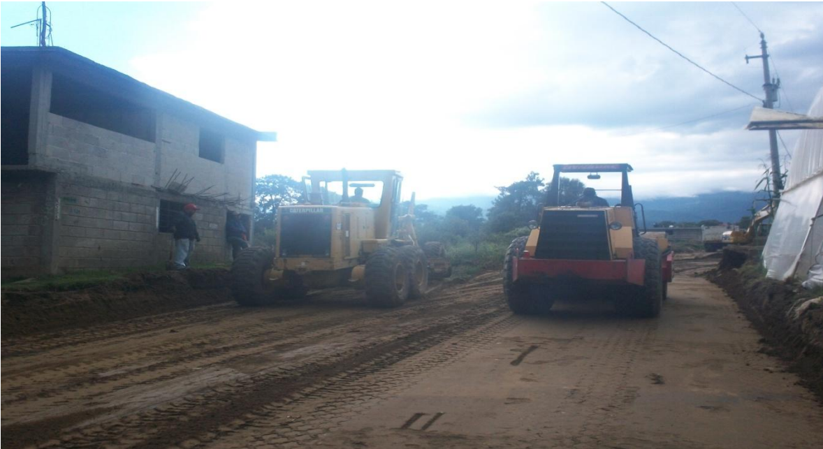
COMPACTACION DE SUBRASANTE
