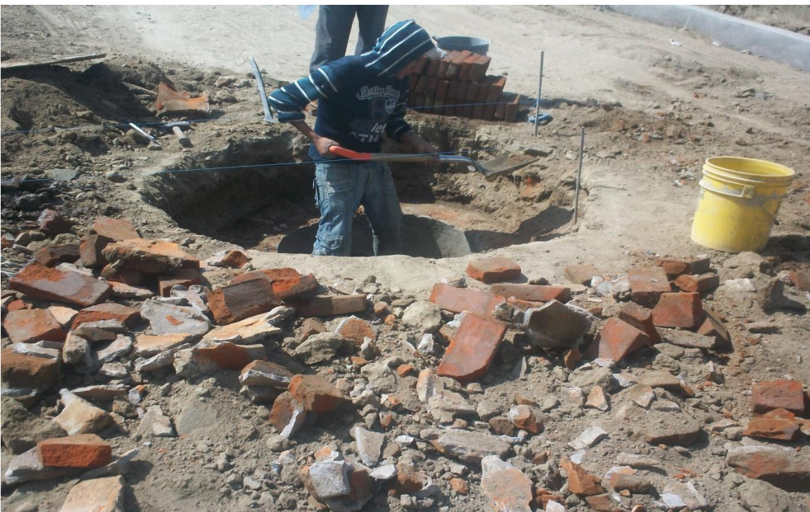
RENIVELACION DE PÓZOS DE VISITA
