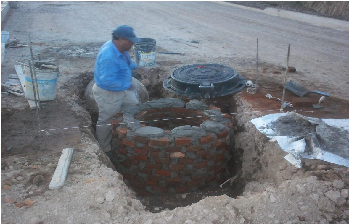
RENIVELACION DE POZOS DE VISITA
