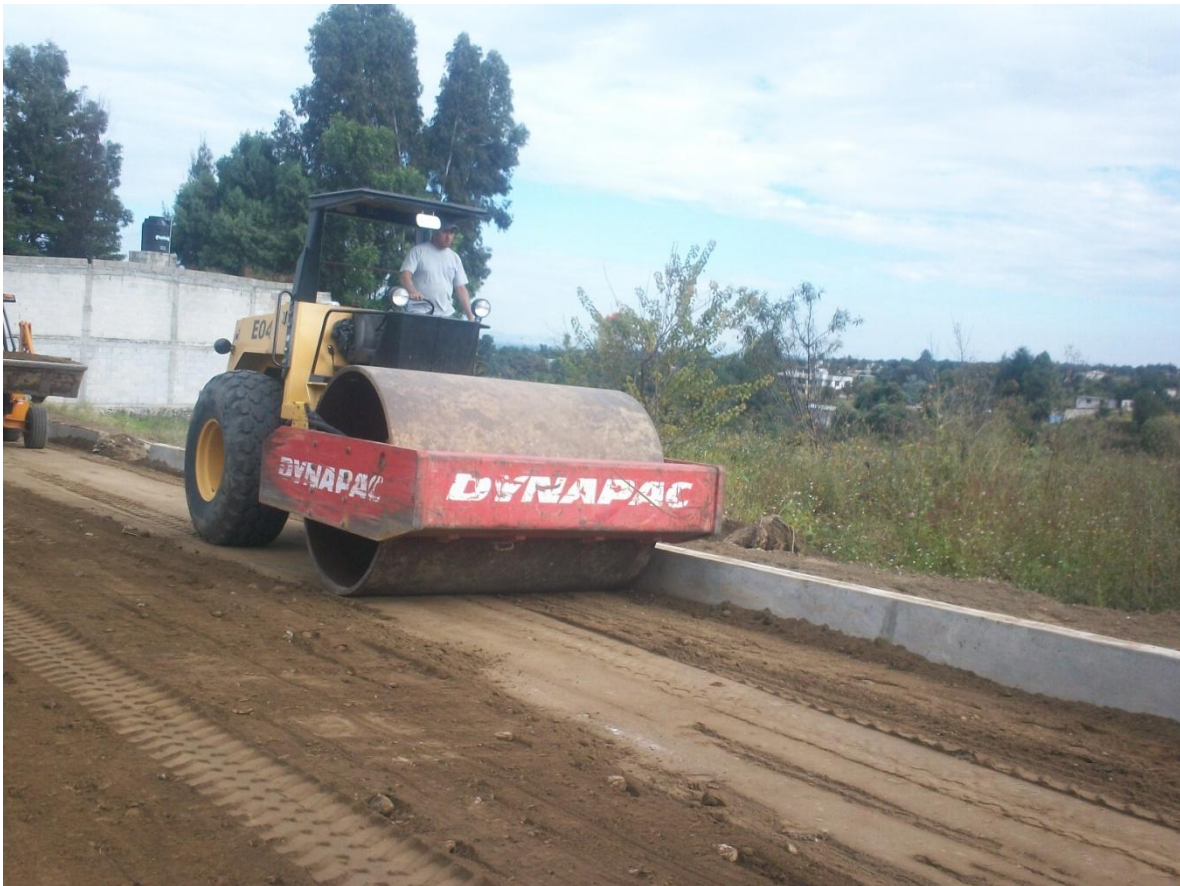
COMPACTACION DE BASE HIDRAULICA
