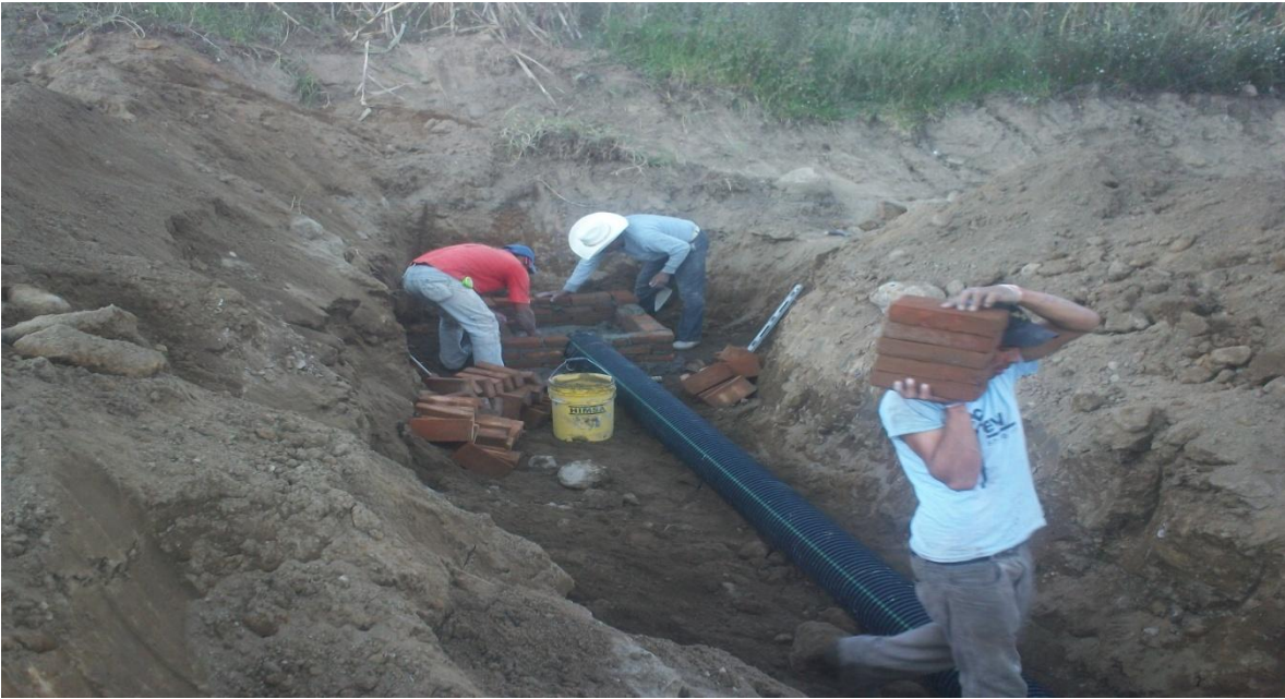
INSTALACION DE TUBERIA DEDESAGUE PLUVIAL
