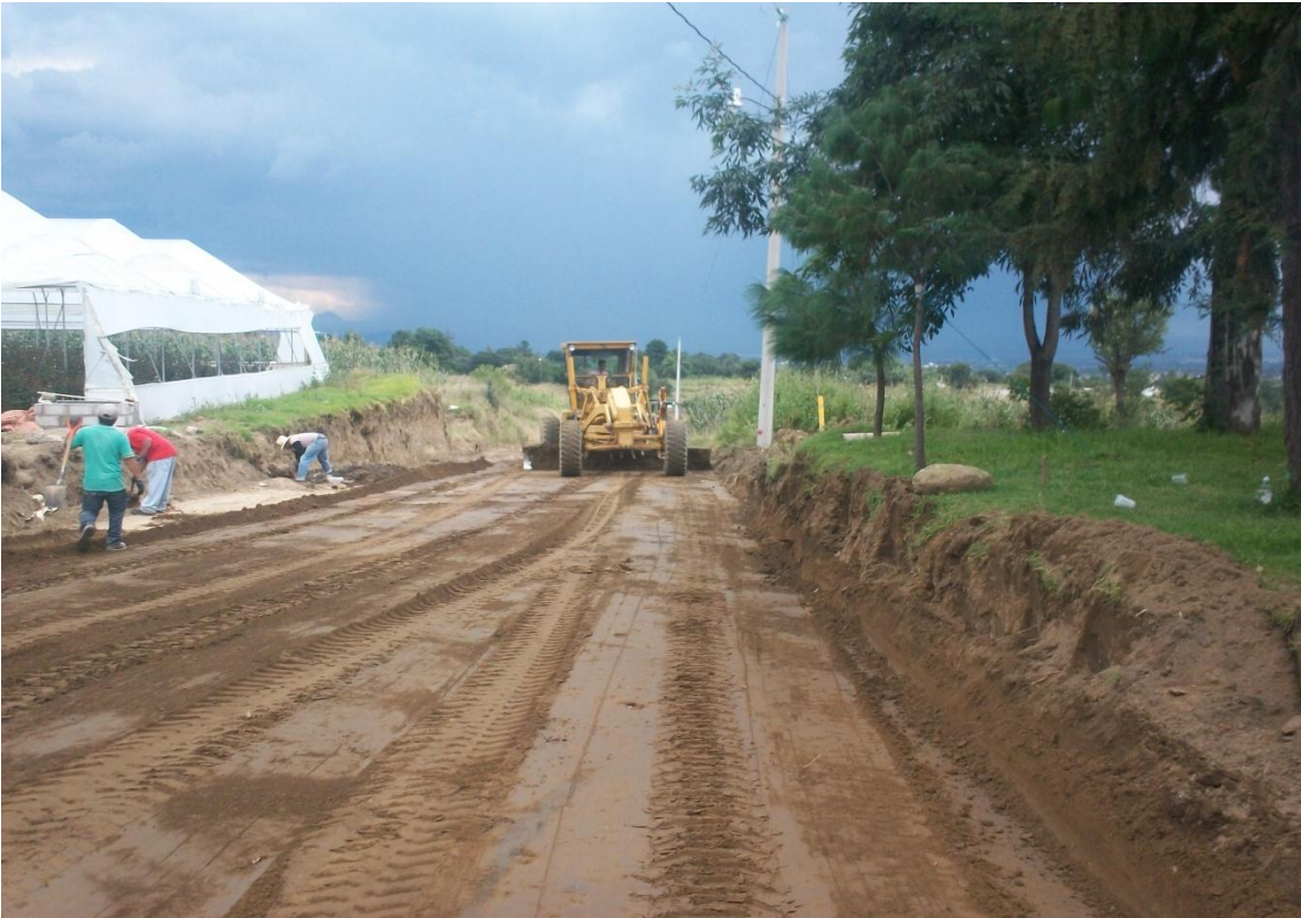
TENDIDO DE SUBRASANTE
