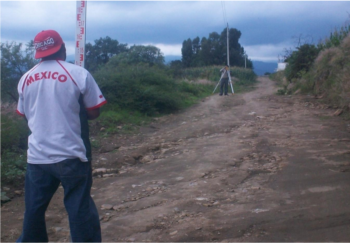
ESTADO ANTERIOR DEL CAMINO
