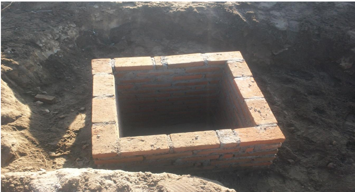
ELABORACION DE BOCA DE TORMENTA
