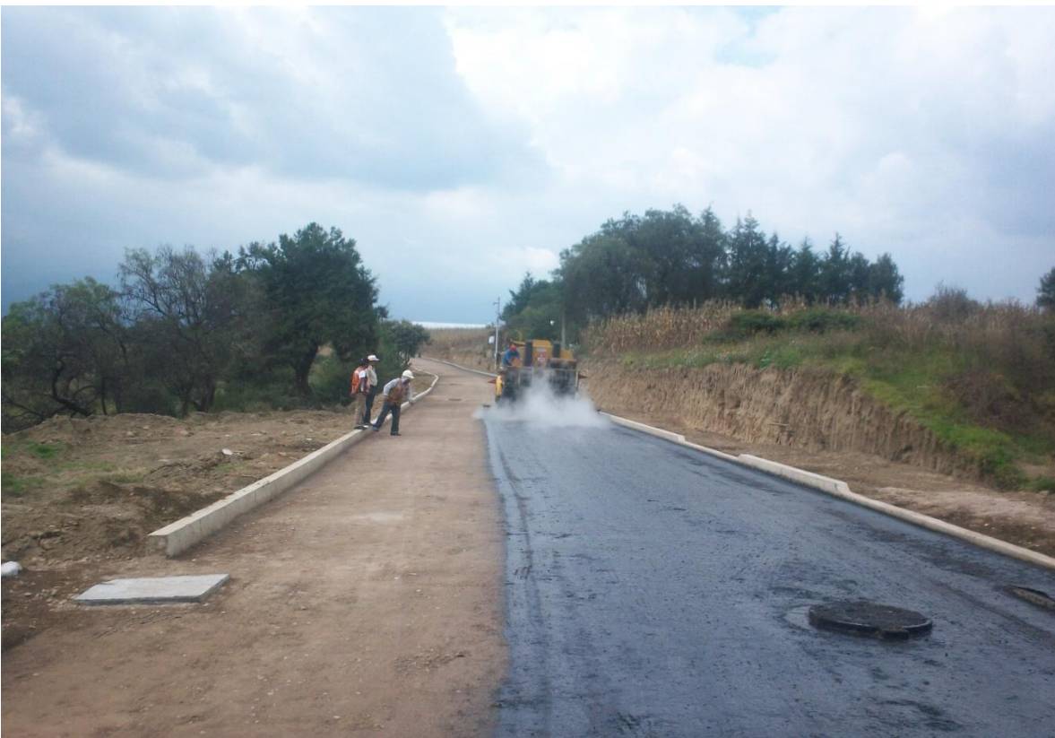
APLICACIÓN DEL RIEGO DE IMPREGNACION
