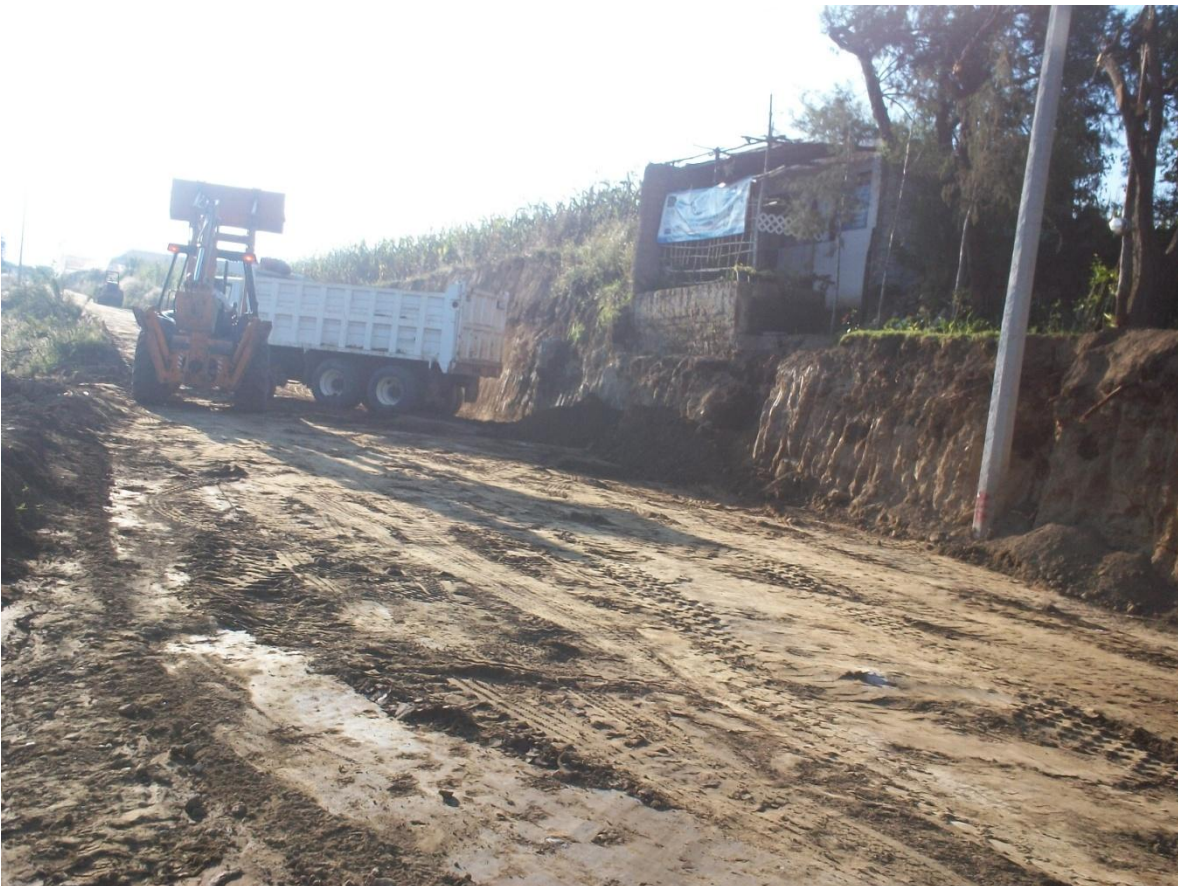
RETIRO DE MATERIAL EXCEDENTE HACIA BANCO DE DESPERDICIO
