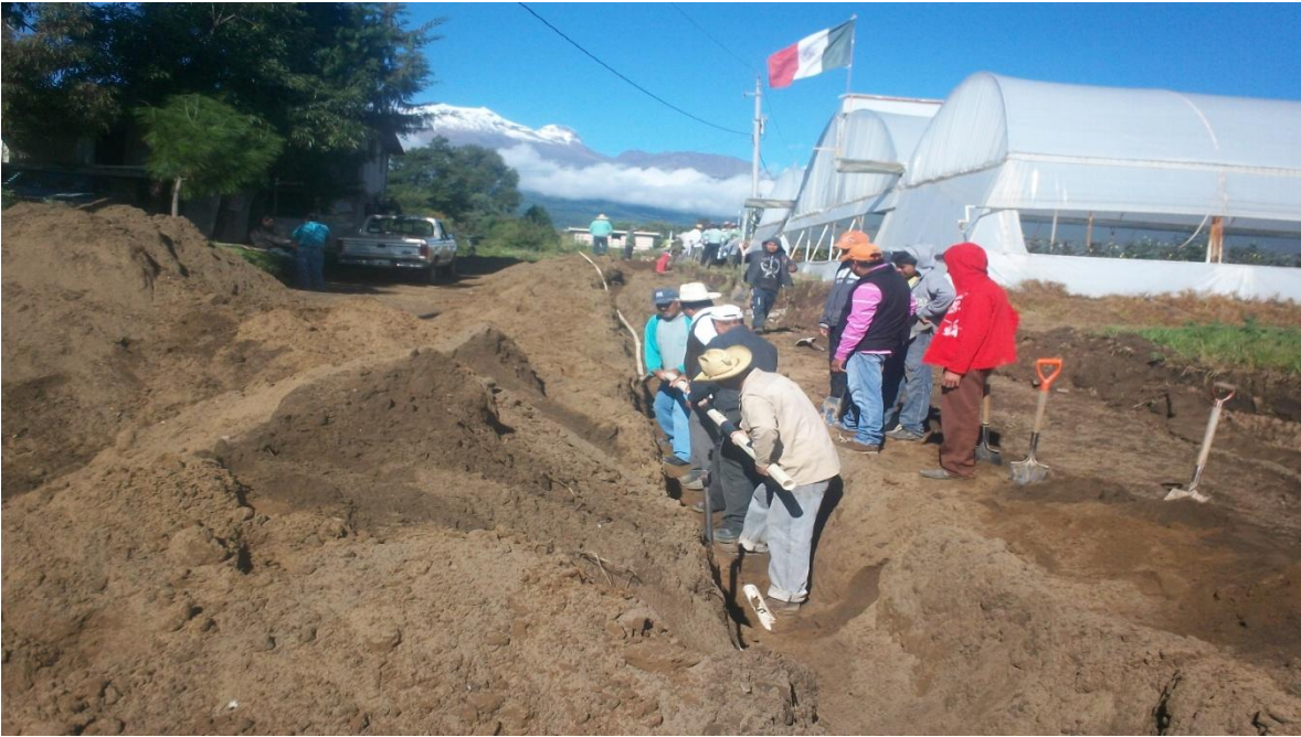
RETIRO DE TUBO DE AGUA DE RIEGO A INVERNADEROS
