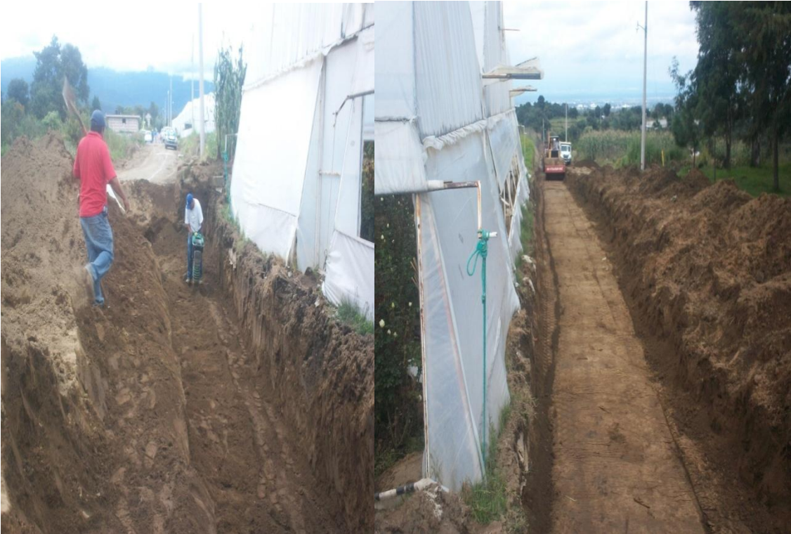
RECOMPACTACION DE CEPAS
