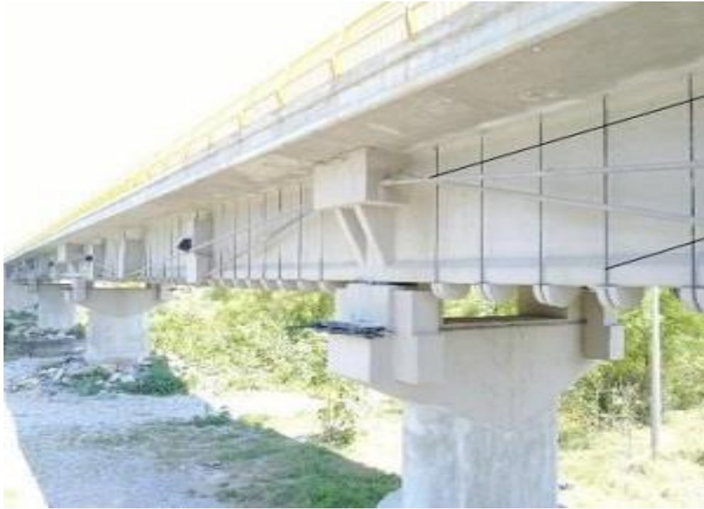
Figura 15 Refuerzo estructural de puente carretero por medio de torones exteriores (Presfuerzo, 2022).
