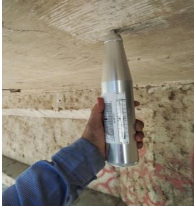
Figura 20 Ensayo de esclerómetro realizado en losa. (autoría propia.)
