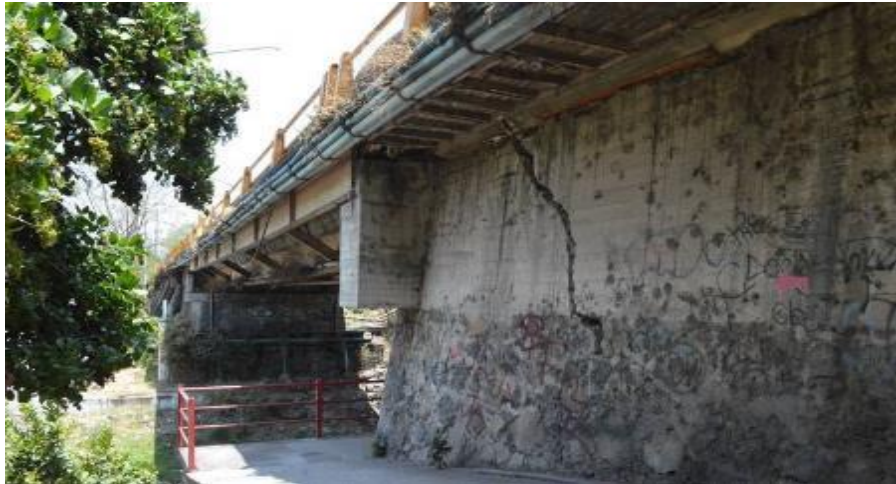
Figura 12 Puente Carlos Pacheco, ubicado en Cuautla, Morelos, (Gaviña, 2022)
