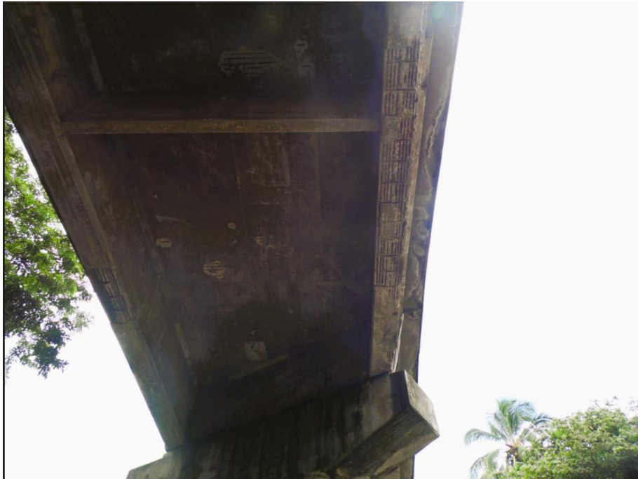
Figura 19 Superestructura vista inferior puente Juñapan (autoría propia).
