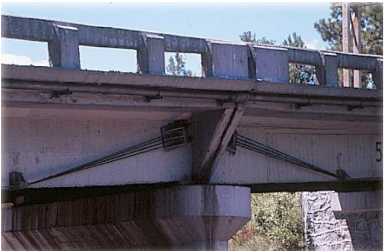
Figura 43 Trabe reforzada con torones externos (Reestructuración de Puentes)
