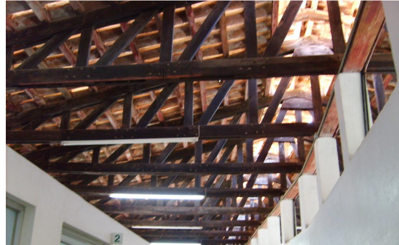
Imagen 2.5.2 Cubierta de los baños individuales, consiste en una armadura de vigería de madera, que soporta la teja de barro, integrando un sistema de ventilación en la cumbrera para la salida de los vapores, sistema del arquitecto vernáculo que sigue funcionando, implementado a base de la observación y el estudio empírico. (Foto: Jesús Romero Solís. Julio 2008)
