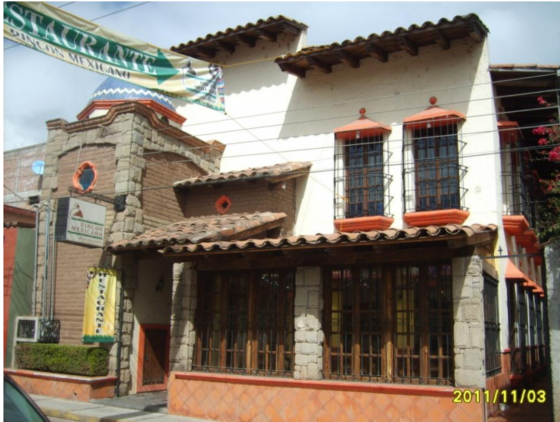
Imagen 4.4.3. Edificio contemporáneo con referentes propios de la región, se emplean en su mayoría materiales sintéticos para imitar la madera, la teja y la piedra, es una combinación de materiales de construcción comunes, y también sustentables procurando una arquitectura en parte responsable, y con identidad regional de Chignahuapan. Donde se ejemplifica que la tradición puede ir de la mano con la modernidad y es una oportunidad del diseño innovador.
