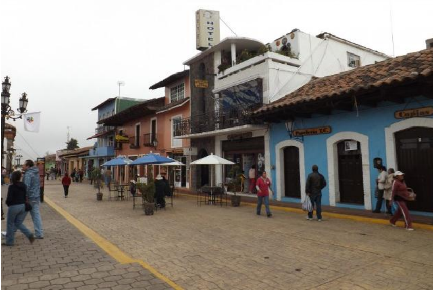
Imagen 4.1.2. Auto-construcción de hotel en el centro histórico de Chignahuapan, claro ejemplo de la patología de identidad que vive esta ciudad. (Foto: Jesús Romero Solís nov. 2011)
