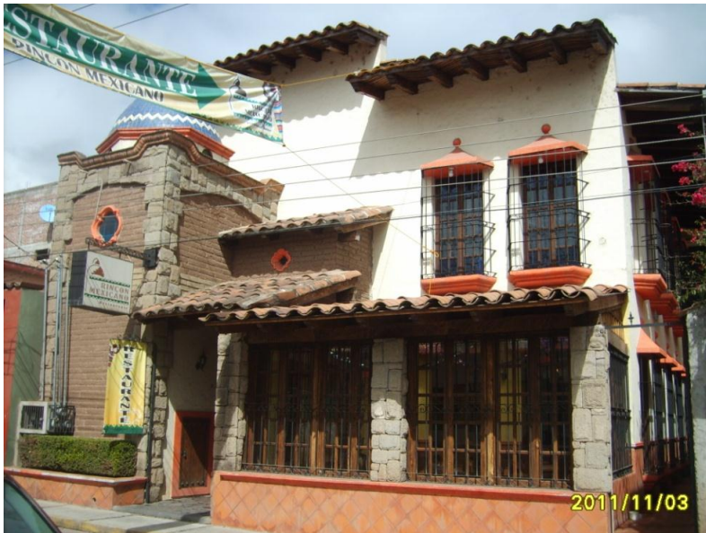
(Imagen 4.1.4) Edificio contemporáneo con referentes propios de la región, se emplean en su mayoría materiales sintéticos para imitar la madera, la teja y la piedra, procurando una arquitectura en parte sustentable, y con identidad regional de Chignahuapan.
