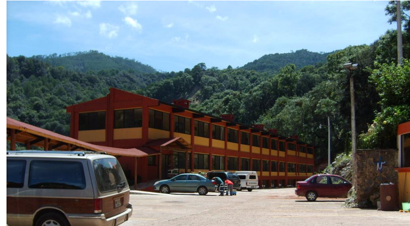
Imagen 2.5.4. Hotel número 3, así le llaman a esta construcción reciente, emplazada dentro del complejo de los Baños Termales de Chignahuapan, (pareciera una escuela tipo CAPFCE 23 ), sin ninguna preocupación por el entorno. (Foto: Jesús Romero Solís. Julio 2008)
