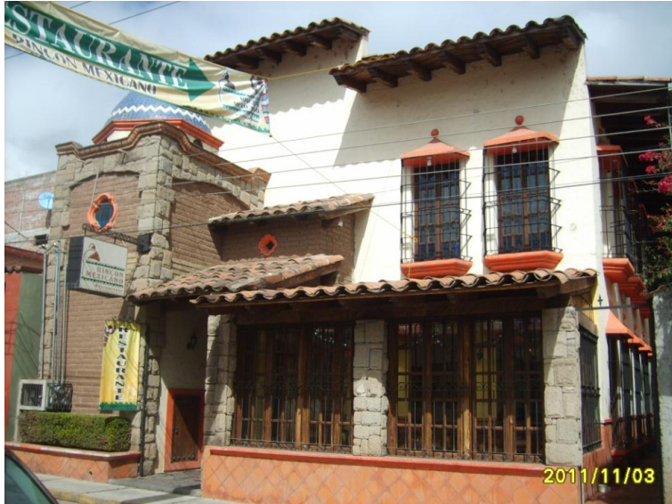
Imagen 1.4.3. Edificio contemporáneo con referentes propios de la región, se emplean en su mayoría materiales sintéticos para imitar la madera, la teja y la piedra, procurando una arquitectura en parte sustentable y con identidad regional de Chignahuapan.
