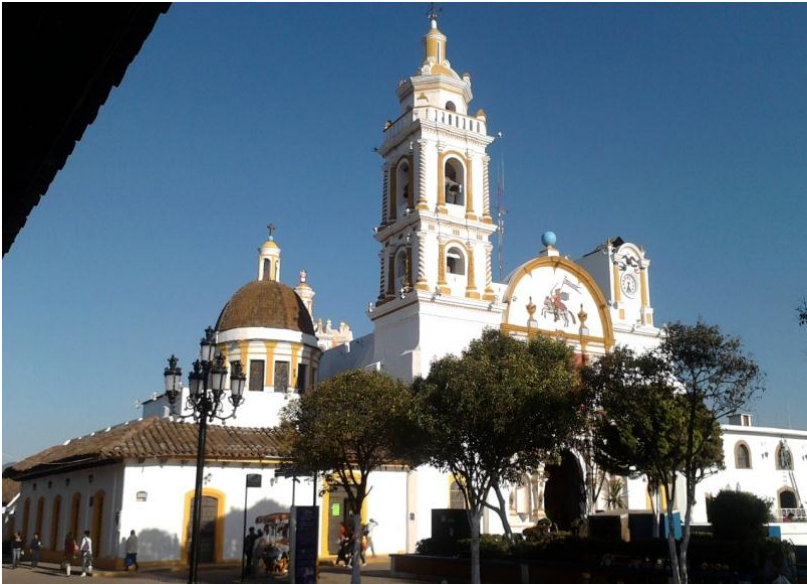
Imagen 3.1.2 Templo de la Parroquia de Santiago Apóstol, Cd de Chignahuapan, uno de los pocos inmuebles que podrían ser considerados como patrimonio de Chignahuapan ya que es ejemplo de tradición y belleza arquitectónica. Se considera creación mestiza, por su estilo barroco indígena. (Foto: Jesús Romero Solís, nov. 2011)
