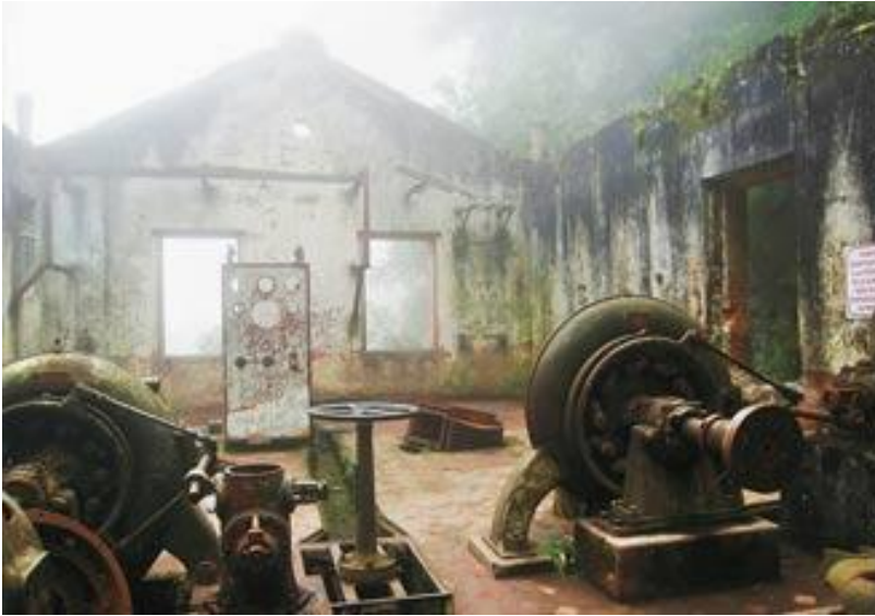
Imagen 1.3.4. Restos de la planta hidroeléctrica de Chignahuapan (foto: Lorena Colín, marzo de 2010)
