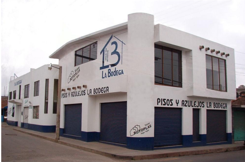
Imagen 2.3.2. Tienda de acabados para la construcción, ubicada dentro del cuadro del centro histórico, el diseño de esta construcción reciente crea inestabilidad en la identidad regional de Chignahuapan, (Foto: Jesús Romero Solís. Julio 2009)
