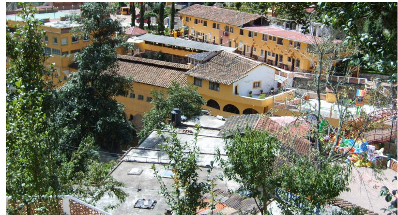
Imagen 1.5.3. Los baños termales de Chignahuapan es deseable que su atractivo perdure, sin embargo, en primera instancia se observa la autoconstrucción desmedida y muy lejos de adaptarse al entorno. No regulada por planeación urbana del municipio. Al fondo: el balneario, hito de Chignahuapan. (Foto: Jesús Romero Solís. Agosto 2008).
