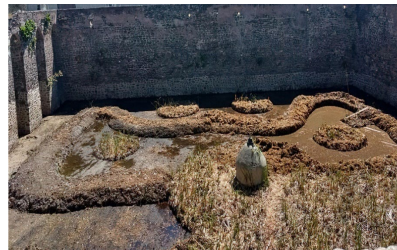
Figura 100. Desazolve realizado en 2019 al fondo del aljibe (Secretaría de Cultura, 2020).
