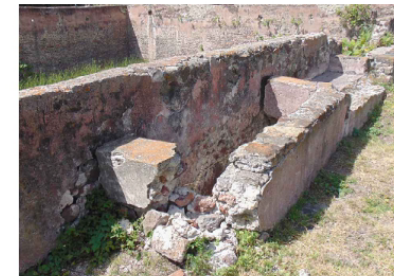
Figura 5. Elemento faltante vano 7 (Magdaleno, 2021).
