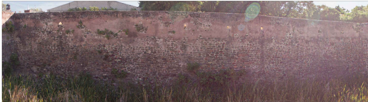
LARGUILLO MURO SUR INTERIOR
