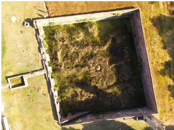
Figura 30. Vista aérea, fondo del aljibe (Magdaleno, 2021).
