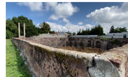
Figura 99. Muro perimetral Sur del aljibe (Magdaleno, 2020).
