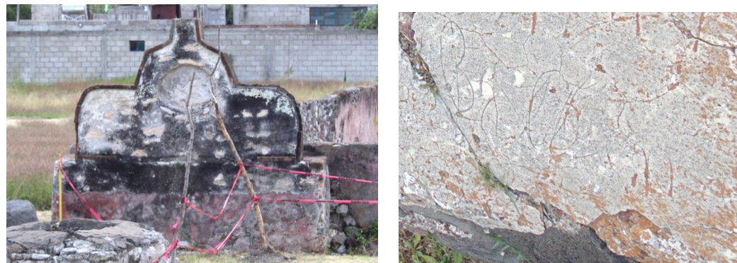
Figuras 33 y 34. Elemento faltante en remate de brocal, izquierda, Magdaleno, 2020. Marcas de relieve por vandalismo, derecha, Magdaleno, 2021.
