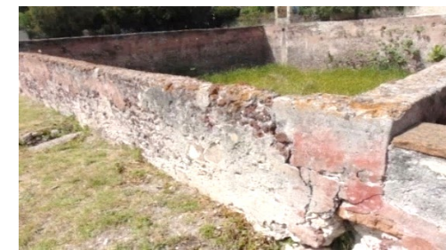
Figura 85. Muro perimetral del aljibe (Magdaleno, 2021).
