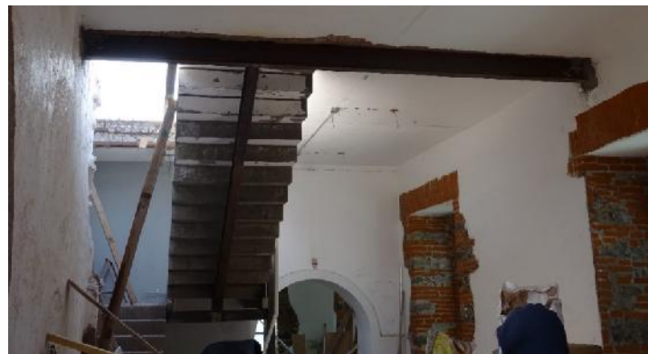
FIGURA N°34 Detalle de vigas de soporte en losa y escaleras. (Fuente: Propia).
