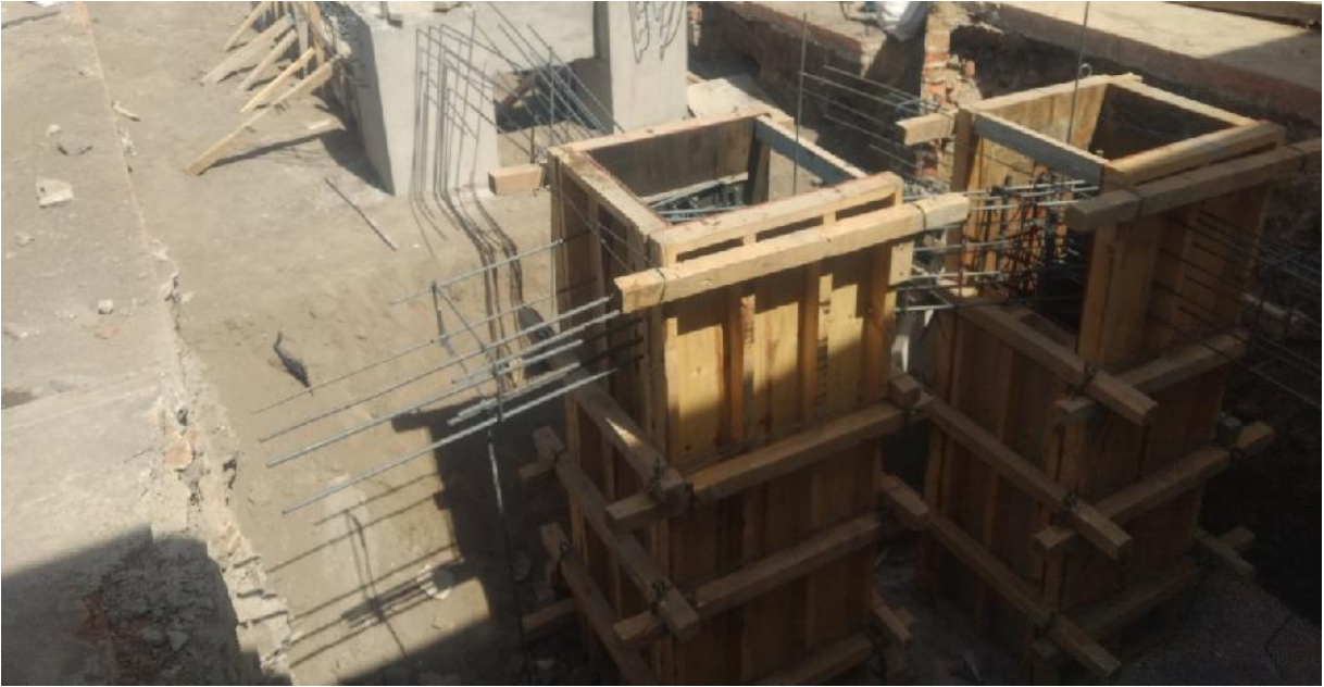
FIGURA N°40 Cimbra de dados en obra. (Fuente: Propia).
