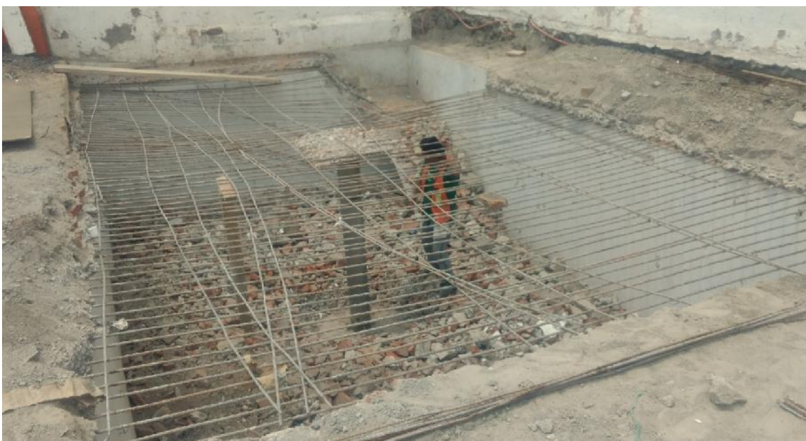
FIGURA N°29 Demolición de losa en patio principal. (Fuente: Propia).
