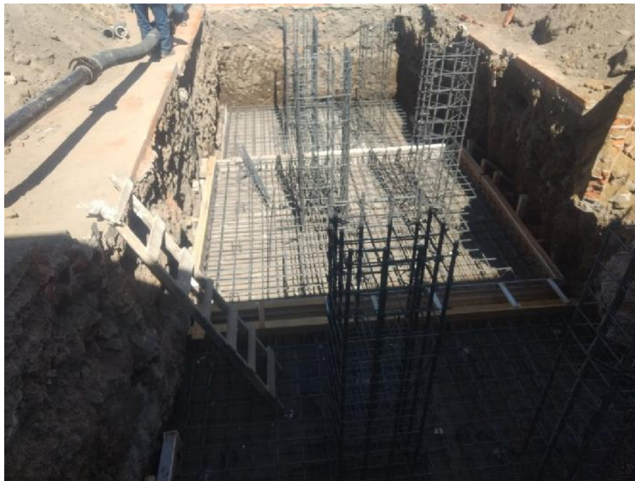
FIGURA N°36 Construcción de zapatas en obra. (Fuente: Propia).
