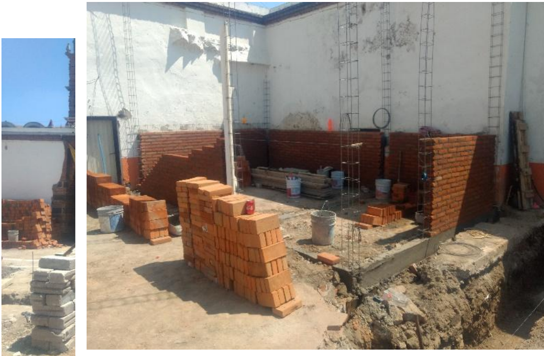
FIGURA N°31 Y 32 Trabajos de albañilería en edificio adjunto. (Fuente: Propia).
