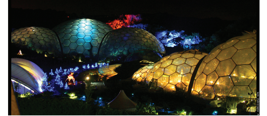
Figura 92. Iluminación The Eden Project.
