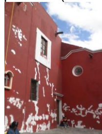
Imagen. Fachada poniente casa de sacerdote anexa a capilla XII estación “La Expiración” (A.A.H. 2016)
