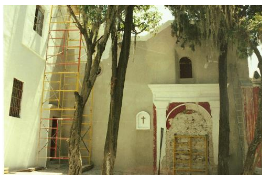
Figura 6. El Calvario, fachada capilla decimotercera estación, Intervención año 1999-2000, Libro blanco, centro INAH Puebla.
