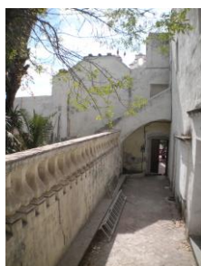
Imagen. Fachada sur casa de sacerdote anexa a capilla XII estación “La Expiración” (A.A.H. 2016)
