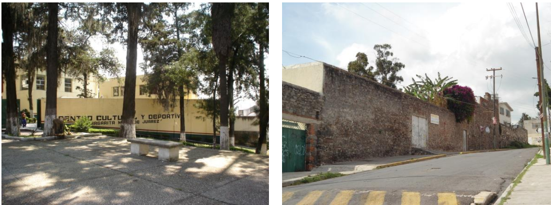
Figura 63. Vista del centro cultural y deportivo “Margarita Maza de Juárez” y del acceso vehicular y de servicios sobre la calle 14 norte, Barrio El Alto (Fuente A.A.H. 2016).
