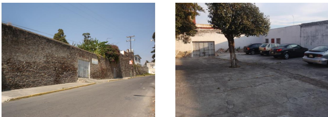
Figura 76. Acceso vehicular y de servicios estacionamiento del conjunto El Calvario, sobre la calle 14 norte (Fuente A.A.H. 2016) y vista interior de estacionamiento (Fuente A.A.H. 2016).
