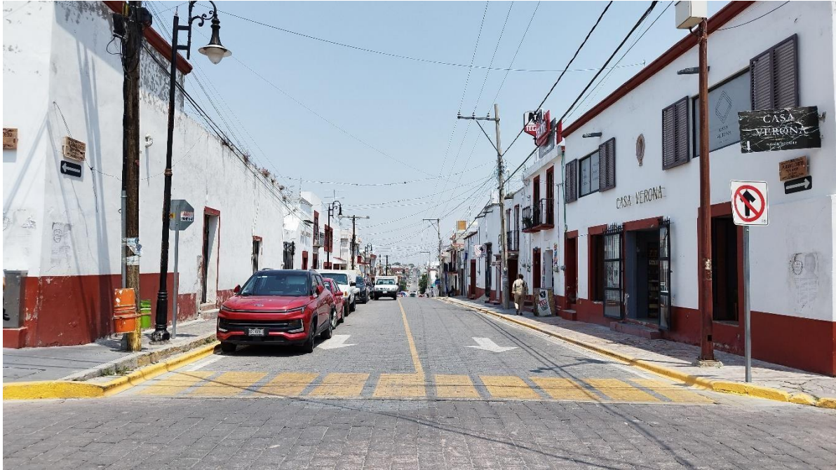
Imagen 6. Estado actual de la calle 25 de agosto. Autoría de Luis Ángel Pérez Alonso. 2023.
