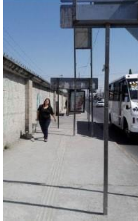
Imagen 2.2: La manera tan sin cuidado y sin seguir lineamientos sobre instalación de señalética, a pesar de ser un espacio recién intervenido, resulta en esto, dificultades para el tránsito de usuarios con mayores dificultades de movilidad, inclusive la huella podotáctil está invadida por estos elementos.
