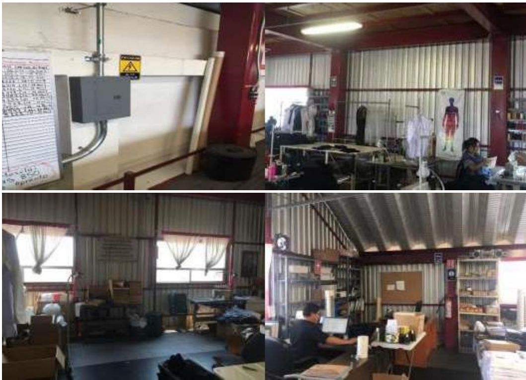
FIGURA 38. Protección contra incendios
