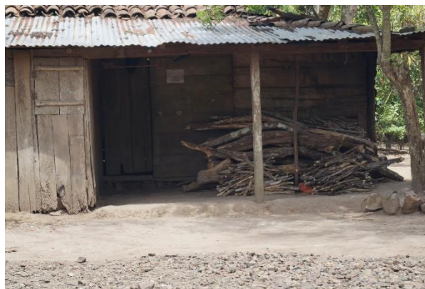
Ilustración 13 Vivienda de madera en Cuetzalan.
