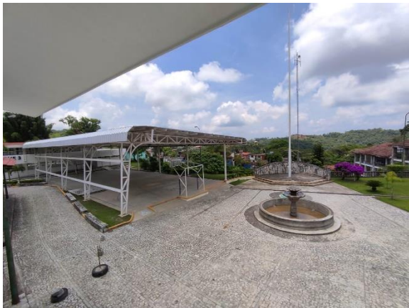
Cancha y fuente, ubicada a un costado del predio donde se propone el centro cultural, esta cancha esta con acceso al público, pero pertenece a la preparatoria BUAP.
