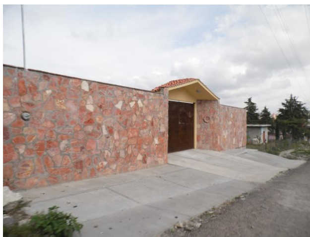
Imagen N°12. Fachada Piedra aparente.
