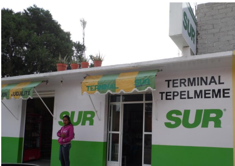
Imagen N° 20. Terminal de Autobuses SUR.
