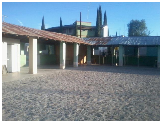
Imagen N°28 detalle de piso y acabados.
