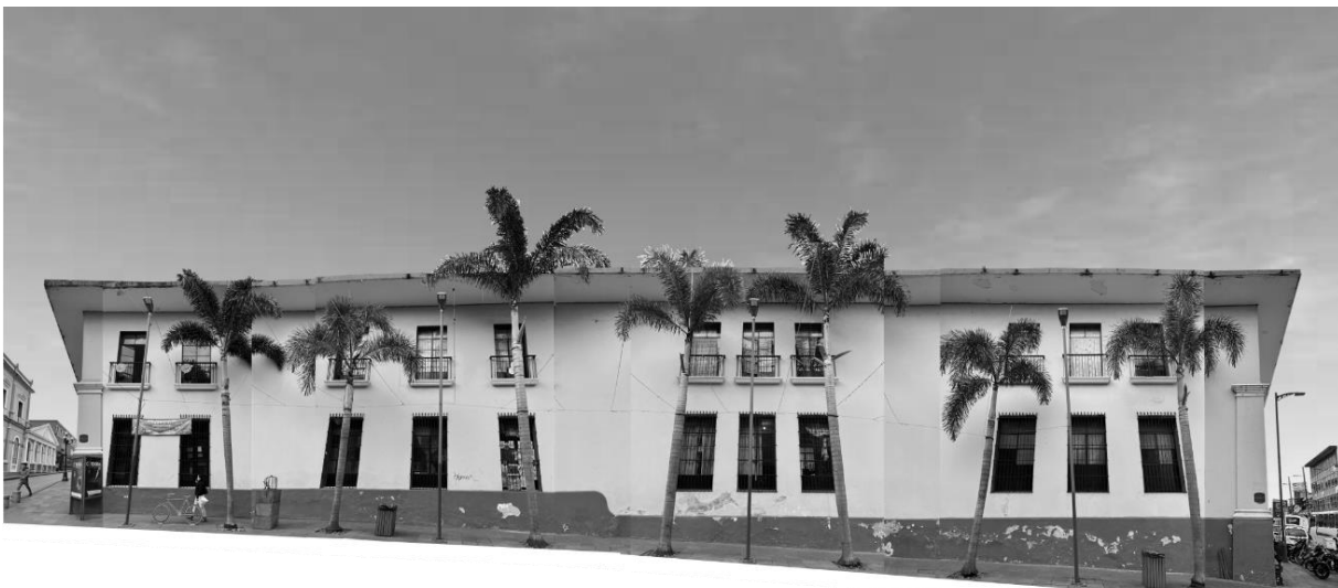
Imagen 36. Perfil fotográfico del estado actual de la calle 1 entre avenidas 1 y 2.
