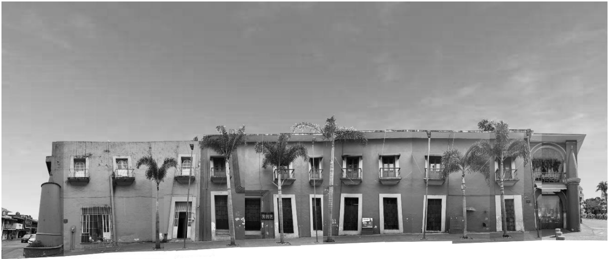
Imagen 34. Perfil fotográfico del estado actual de la calle 1 entre avenidas 1 y 2.
