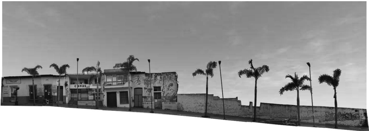
Imagen 28. Perfil fotográfico del estado actual de la calle 1 entre avenidas 3 y 5.
