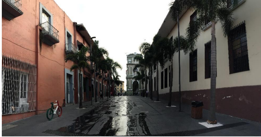
Estado actual. Calle 1 entre avenidas 1 y 2.
