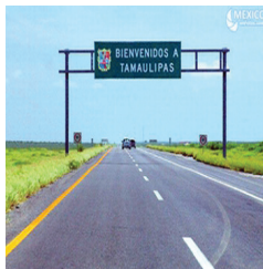
Figura 28. Señal de banda. (google images [en línea])
