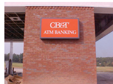
Figura 64. Señal colocada de forma adosada sobre una pared de ladrillo. (google images [en línea])
