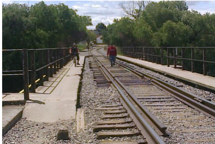
IMAGEN 23: ESTADO ACTUAL DE PUENTE PEATONAL FERRED
