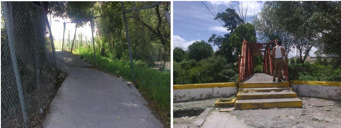
IMAGEN 15,16: VISTAS DEL PUENTE PEATONAL PATRIOTISMO
