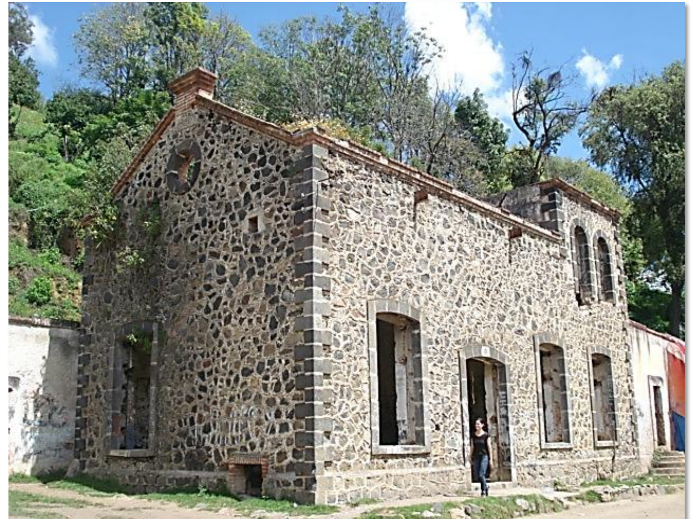
Fotografía de la antigua hidroeléctrica de San Pedro Atlixco.
