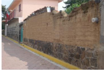
Muro de adobe en calle prolongación Avila Camacho, como en las imágenes anteriores, se observa el uso de la piedra volcanica en la parte inferior del mismo.
