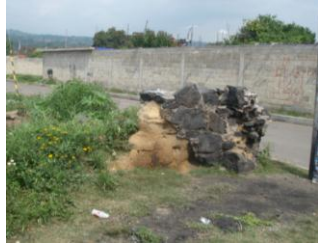
Hallazgos de lo que fue una vivienda en la calle Olímpico deportivo, se observa un modo de construcción diferente a los anteriores, ya que el muro de adobe se forra de piedra volcanica.
