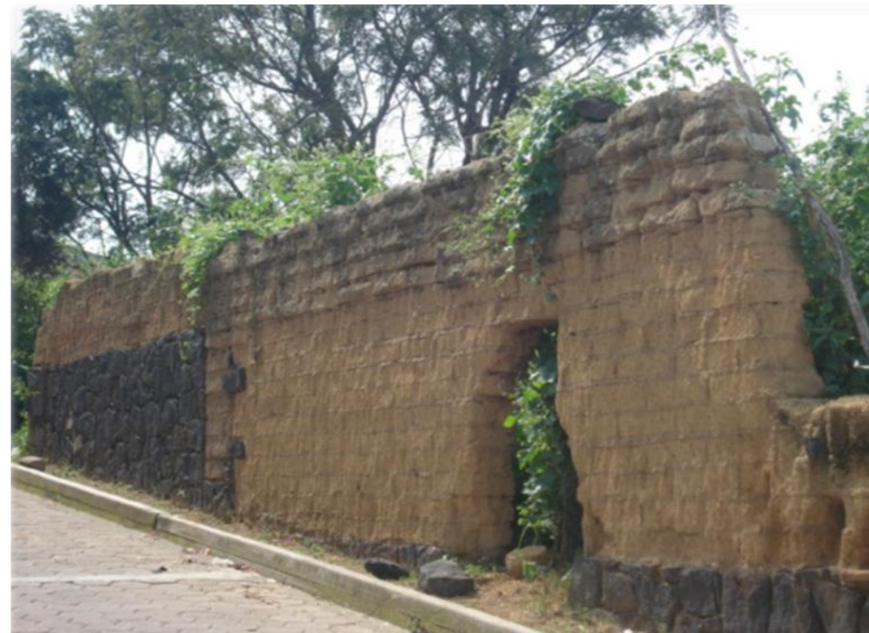
Fotografía de muro hecho de adobe con piedra volcánica como base, tomada en San Pedro Atlixco
