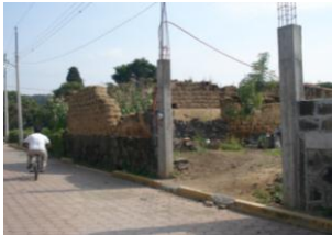
Muros de adobe y piedra volcanica en calle Josefa Ortiz de Dominguez, con el mismo metodo de construcción, empleando la piedra volcanica en la parte inferior de los muros
