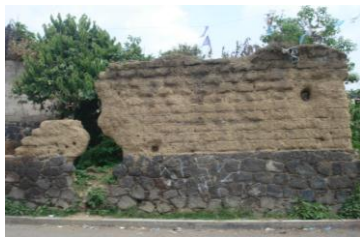
Hallazgos de lo que fue una vivienda en la calle Benito Juárez, entre Olímpico deportivo y la calle Josefa Ortiz de Domínguez, al igual que en las anteriores se observa el mismo modo de construcción con la piedra volcanica como base.
