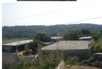
Fotografía tomada en una de las partes más altas de la localidad, que es donde se encuentra la iglesia.
