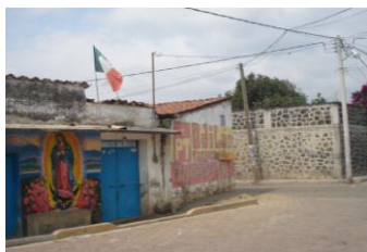
Vivienda en esquina de calle 16 de septiembre, enfrente de la presidencia auxiliar, estas viviendas se conservan de adobe con repellado.
