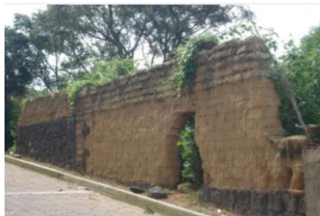
Muro de adobe en calle 16 de septiembre.
