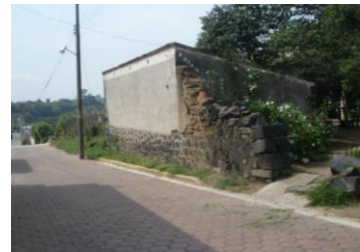
Muro de piedra volcanica con adobe, junto a casa ubicada en calle Benito Juárez
