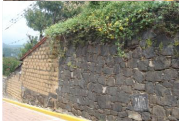
Casa en esquina de calle Benito Juárez y Josefa Ortiz de Domínguez, actualmente habitada; con la combinación de piedra volcanica y adobe. Sus techos con la pendiente original.
