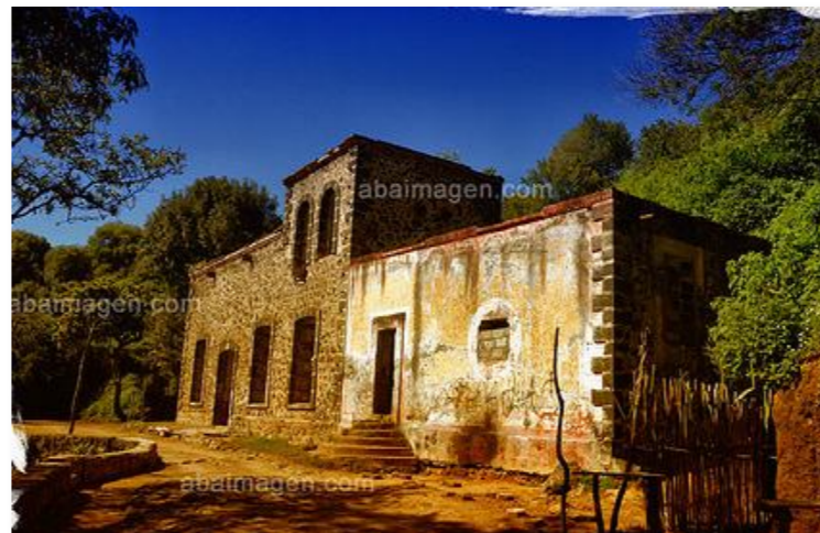
Fotografía del edificio de la antigua hidroeléctrica de San Pedro Atlixco.
