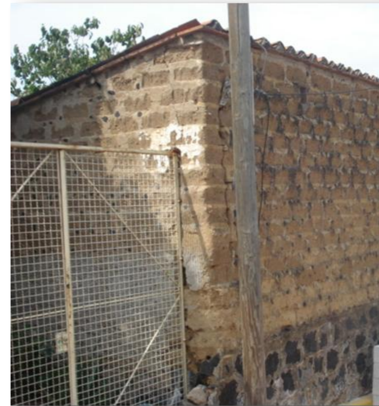
Fotografía tomada en San Pedro Atlixco por el equipo de tesis. Muro aparente de adobe se puede apreciar la cimentación de piedra volcánica y las juntas con piedras pequeñas.
