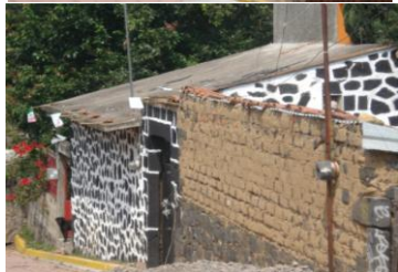
Casa de adobe y piedra actualmente habitada en calle Josefa Ortiz de Domínguez. A pesar de que su techumbre es de lamina de zinc, los muros se encuentran en buen estado.
