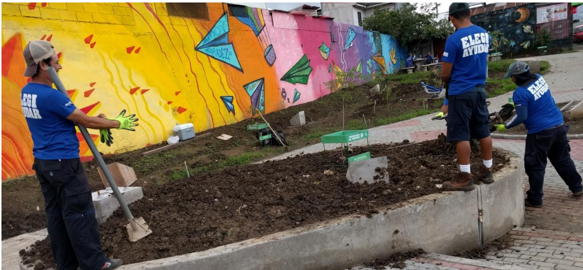
Fig. 1.11 Obras de construcción
