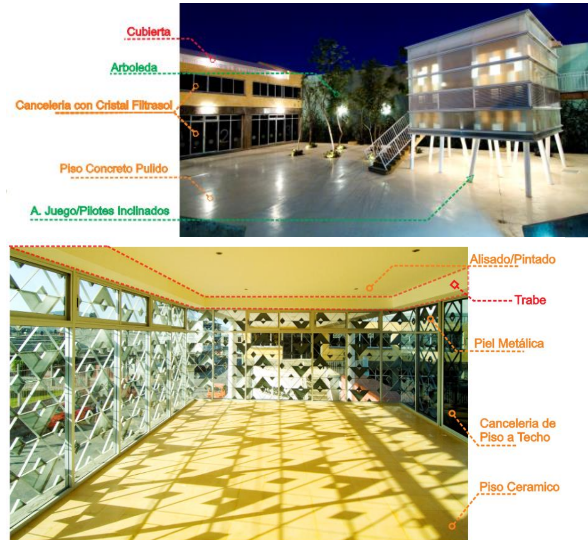
Fotografía 9 Explanada y Sala Multiusos - CCC
