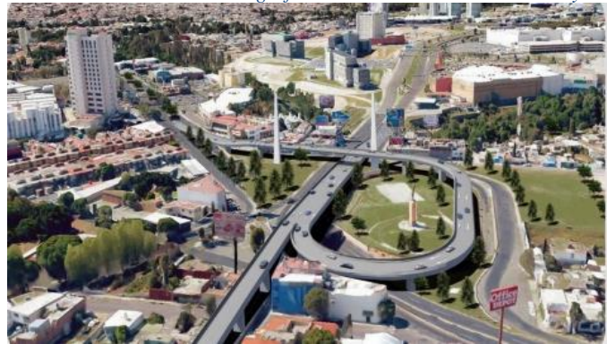
Fotografía 16 Vista Aérea Puente Atlixcayotl
