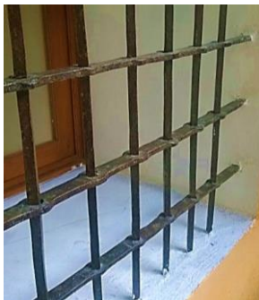
Ilustración 19 Trabajo de perforación en solera. Herrería Siglo XVII (Foto del autor 2015)
