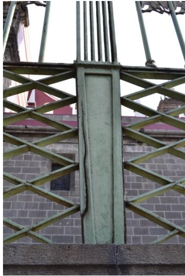
Ilustración 70 Oxidación y corrosión en elementos (Foto del Autor 2014.)
