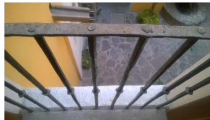
Ilustración 20 Trabajo de remachado en barandal. Herrería Siglo XVII (Foto del autor 2015)
