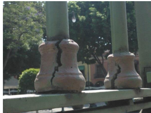
Ilustración 71 Estallamiento de elementos de plomo (Foto del Autor 2014).
