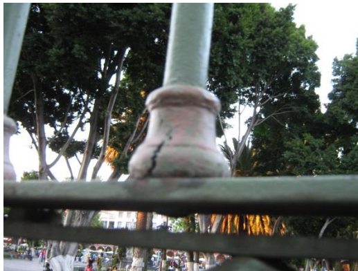
Ilustración 71 Estallamiento de elementos de plomo (Foto del Autor 2014).
