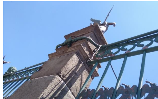
Ilustración 75 Sujeción de cableado a todo lo largo de la parte superior de los tramos o secciones. (Fotos del Autor 2014)
