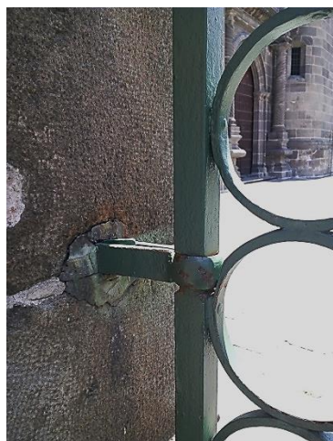
Ilustración 77 Detalle en gozne mal anclado a la cantera (Foto del Autor 2014)
