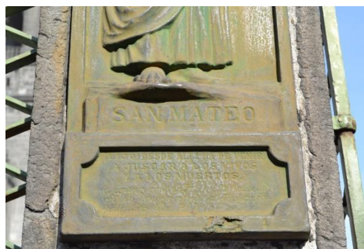
Ilustración 72 Grado de deterioro: MODERADO (Foto del Autor 2014)
