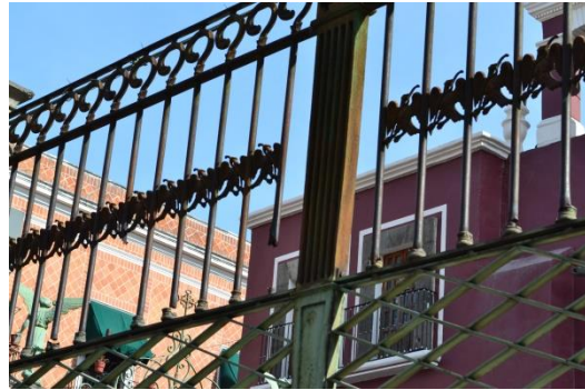
Ilustración 70 Oxidación y corrosión en elementos (Foto del Autor 2014.)
