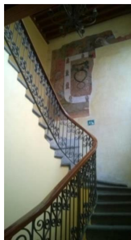
Ilustración 12 Barandal de escalera "Preparatoria Emiliano Zapata" (foto del autor 2014)
