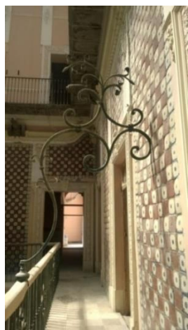
Ilustración 13 Soporte de barandal con curvaturas roladas "Edificio Arronte" (foto del Autor 2014)
