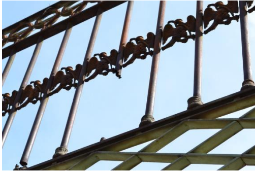
Ilustración 74 Barrotes cortados por acción humana (Foto del Autor 2014)
