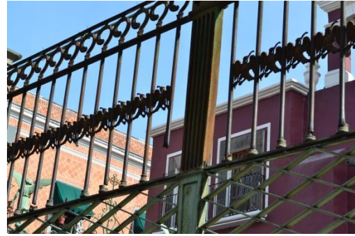
Ilustración 74 Barrotes cortados por acción humana (Foto del Autor 2014)
