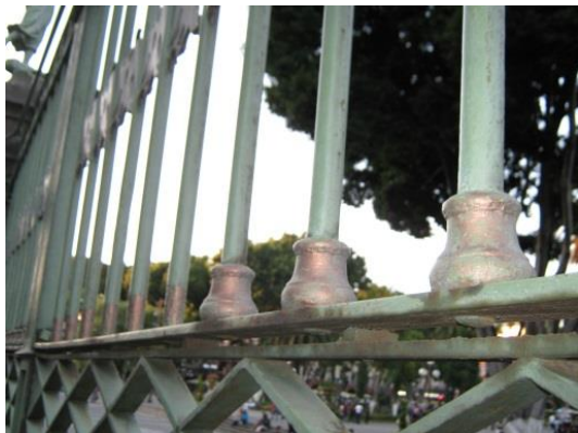
Ilustración 76 Ejemplo de pintura mal aplicada en algunas àrea y en otras la falta de este recubrimiento (Foto del autor 2015)
