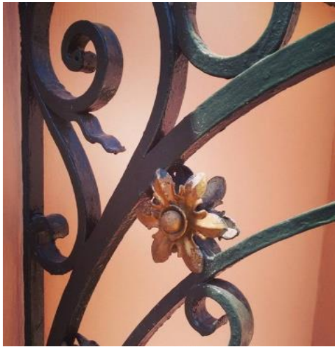
Ilustración 18 Detalle en ménsula de marquesina Siglo XIX. (Foto del autor 2016)
