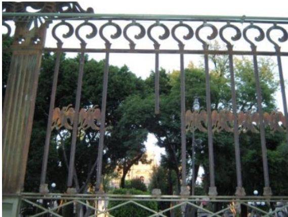
Ilustración 63 Perdida de barrote por medios mecánicos. (Foto del Autor 2014)
