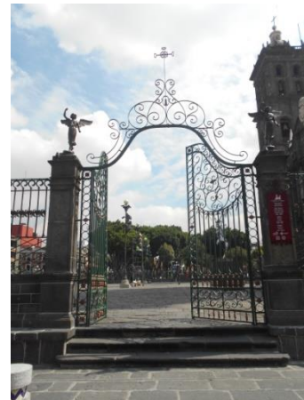
Ilustración 54 Acceso Principal Puente (Foto del Autor 2015)
