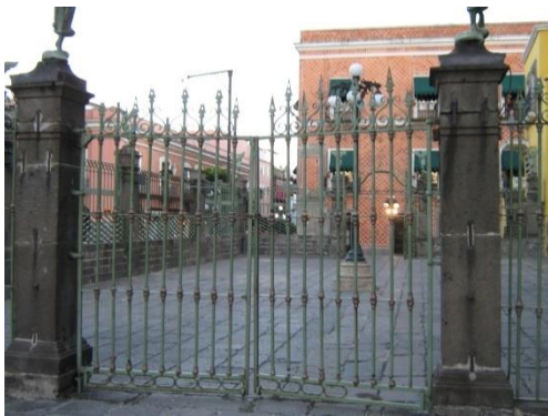
Ilustración 79 Acceso interno al Sagrario, ya no es posible su abatimiento por el vencimiento del elemento (Foto del Autor 2014)
