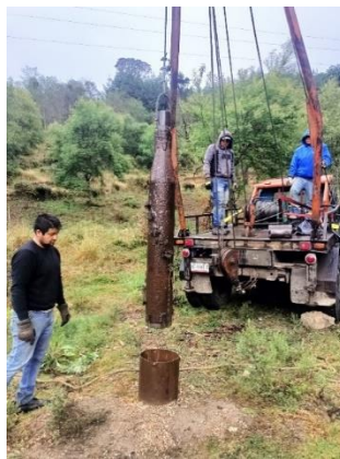
Imagen 20 propia. - “CEPILLADO DE POZO PROFUNDO EN EL MUNICIPIO DE ATEMPAN PUEBLA” (2023)
