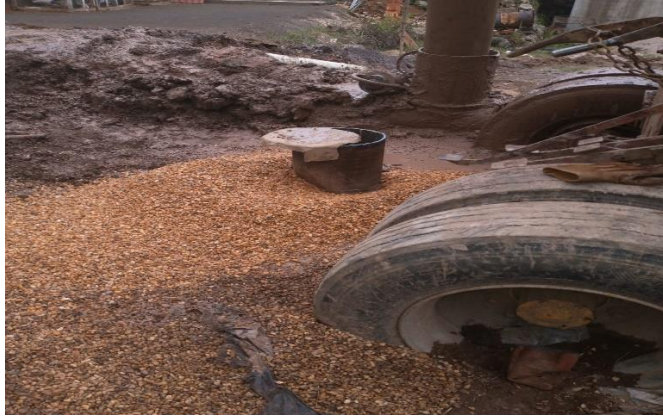
Imagen 7.- TERMINACIÓN DE POZO (PROYECTO POZO TEZOMPAN) 2021
