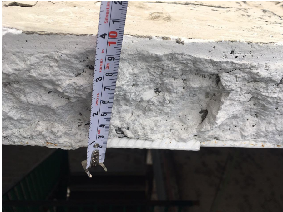
Figura 2.2 Levantamiento del edificio. Verificación del espesor de la losa.
