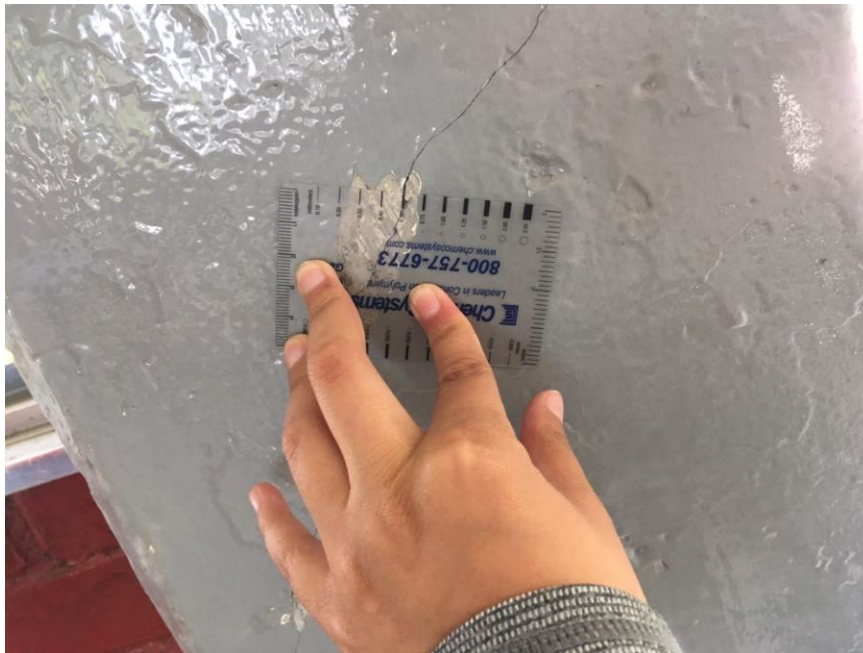
Figura 2.9 Daño por cortante observado en la columna del Eje 4 en sentido longitudinal, agrietamiento de 0.50 mm de espesor.
