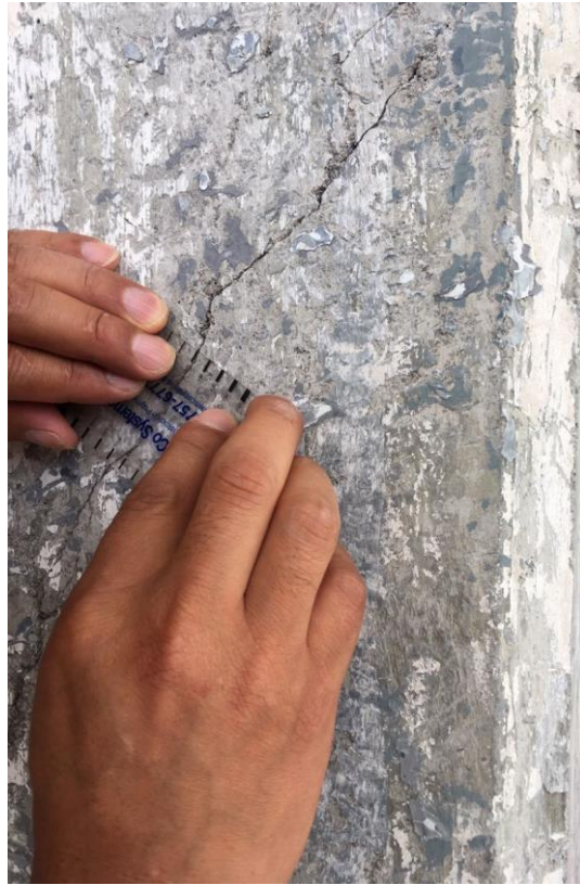
Figura 2.16 Daño por cortante observado en la columna del Eje 12 en sentido longitudinal y transversal, agrietamiento de 1.00 mm de espesor.
