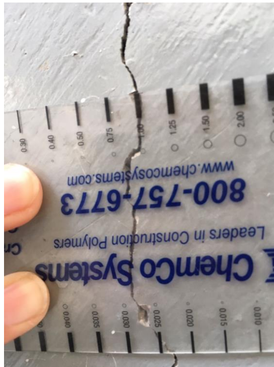
Figura 2.12 Daño por cortante observado en la columna del Eje 9 en sentido longitudinal, agrietamiento de 0.50 mm de espesor.
