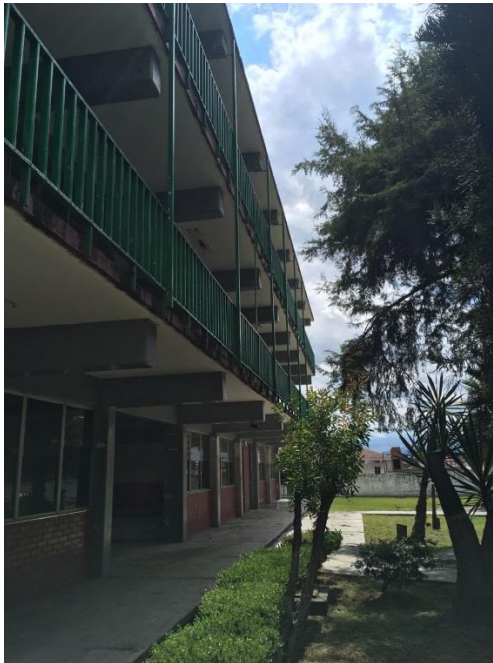
Figura 2.1 Estructura de uso estudiantil de concreto reforzado.
