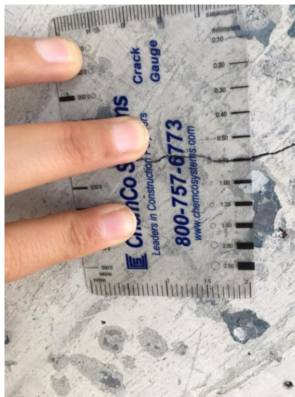
Figura 2.9 Daño por cortante observado en la columna del Eje 4 en sentido longitudinal, agrietamiento de 0.50 mm de espesor.
