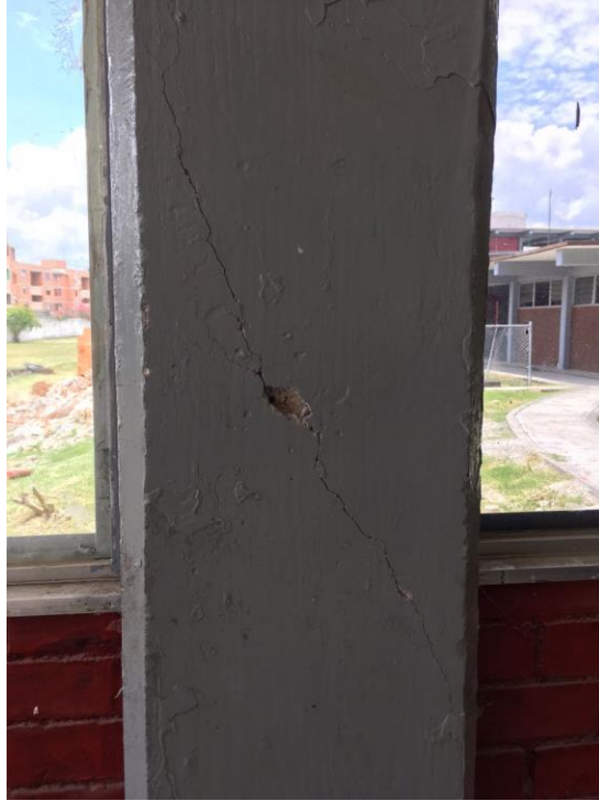
Figura 2.14 Daño por cortante observado en la columna del Eje 11 en sentido longitudinal, agrietamiento de 1.00 mm de espesor.
