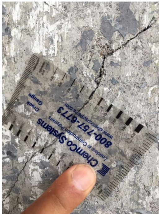
Figura 2.14 Daño por cortante observado en la columna del Eje 11 en sentido longitudinal, agrietamiento de 1.00 mm de espesor.
