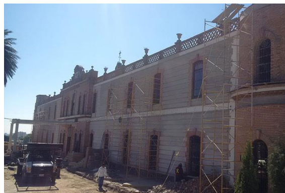
Imagen 31. Obras de rehabilitación en Hospital de Nuestra Señora de Guadalupe, Cholula, Puebla. Obtenida de http://www.municipiospuebla.com.mx/nota/2016-02-11/san-andr%C3%A9s-cholula/pesar-de-amparo-siguen-obras-en-ex-hospital-de-cholula el 29 de noviembre de 2016.
