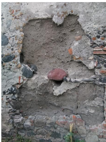
Figura 78. Muro colindante con huerto, destacando materiales. Arq. Nayeli Durán Lozano el 08 de noviembre de 2016.
