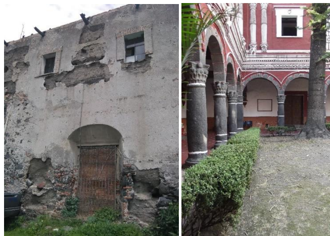
Figuras 96 y 97 Apoyos en el ex hospital de San Juan de Dios, muros de carga de mampostería y tabique y columnas de piedra de cantera. Tomadas por Arq. Nayeli Durán Lozano el 19 de enero de 2017.
