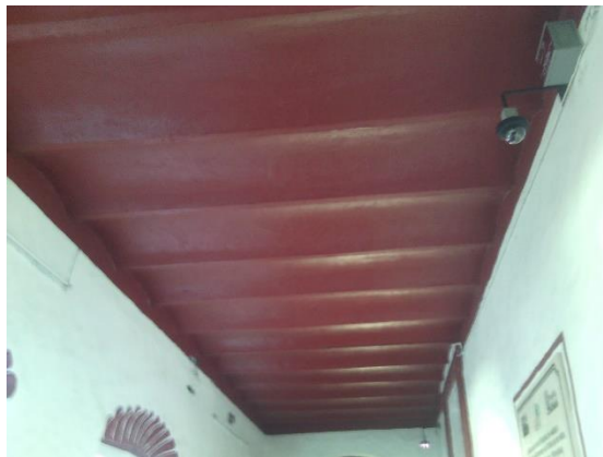
Figuras 98 y 99. Tipos de cubiertas en el ex hospital de San Juan de Dios, con viguería y enladrillado y bóveda catalana. Tomadas por Arq. Nayeli Durán Lozano el 19 de enero de 2017.
