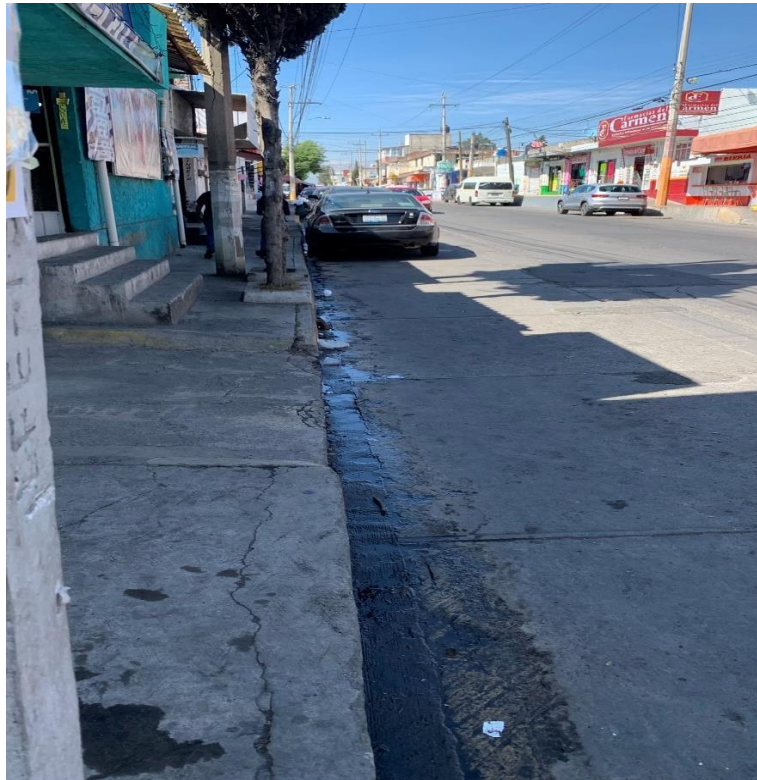
Imagen 14. Del lado izquierdo de la figura observamos como el poste y el escalón para acceder al predio obstruyen la franja de circulación peatonal, haciendo el difícil tránsito de peatones.
