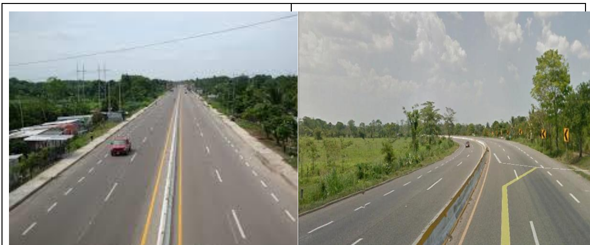
Figura 14 señalamiento horizontal líneas centrales
