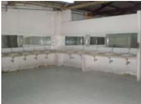
Área de sanitarios.
