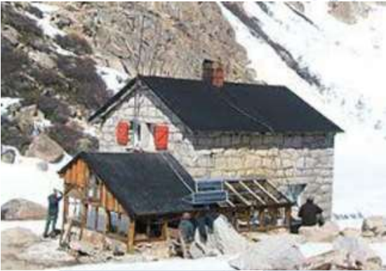
Refugio Frey, San Carlos de Bariloche, Argentina.
